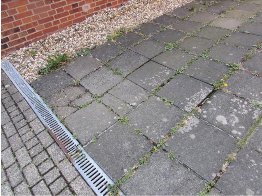
Foto 7: Zufahrt: beschädigte, abgesetzte Betonplatten
