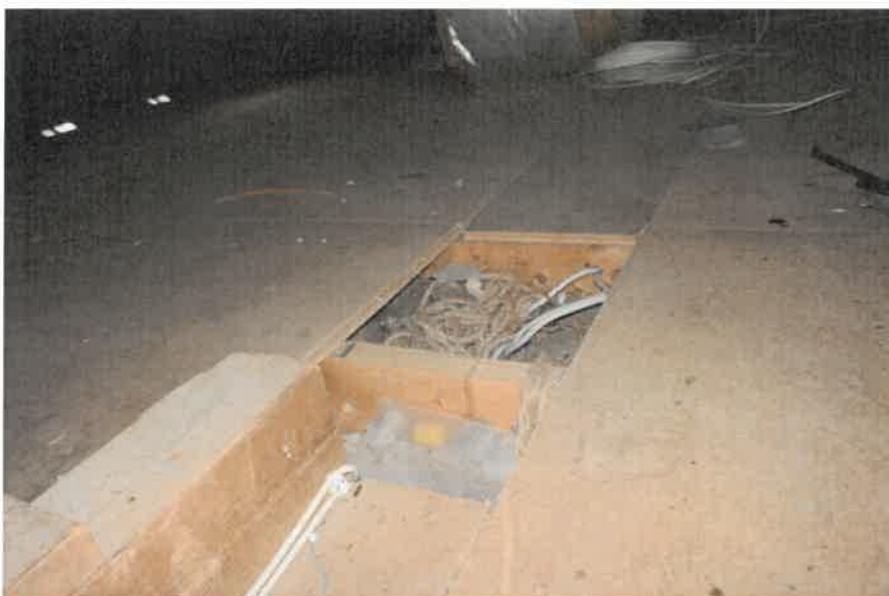
Dämmung auf oberster Geschosßdecke
