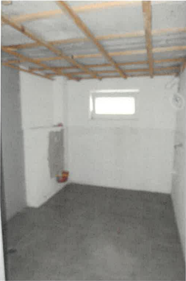
Kellerraum - Vorbereitung für Duschbad
