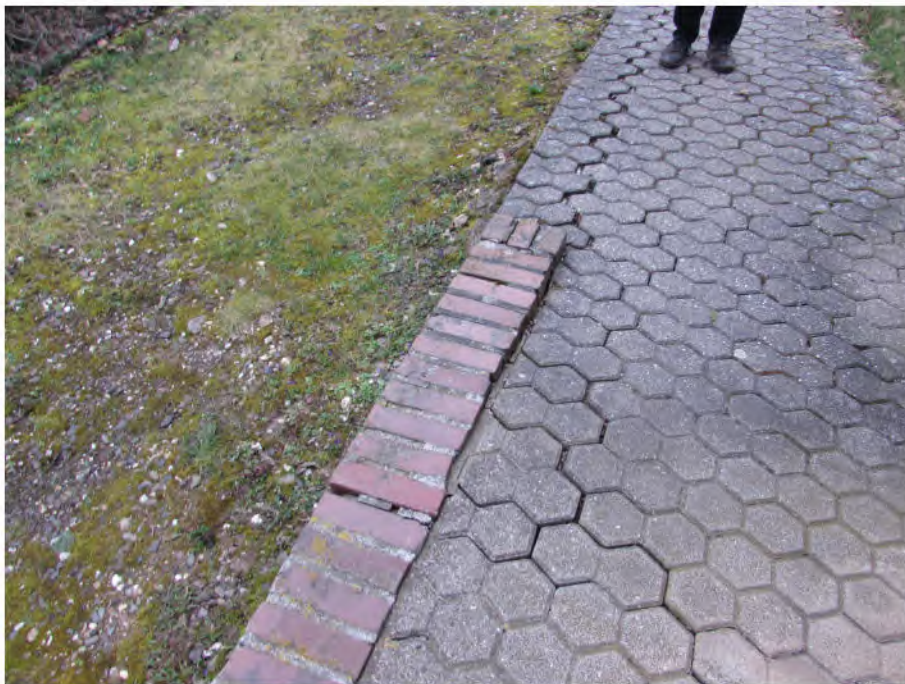
Foto 12: abgesetzte Wegbefestigung
