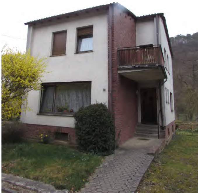
Foto 1: Einfamilienhaus „Zerkaller Straße XX, Nideggen-Brück“
