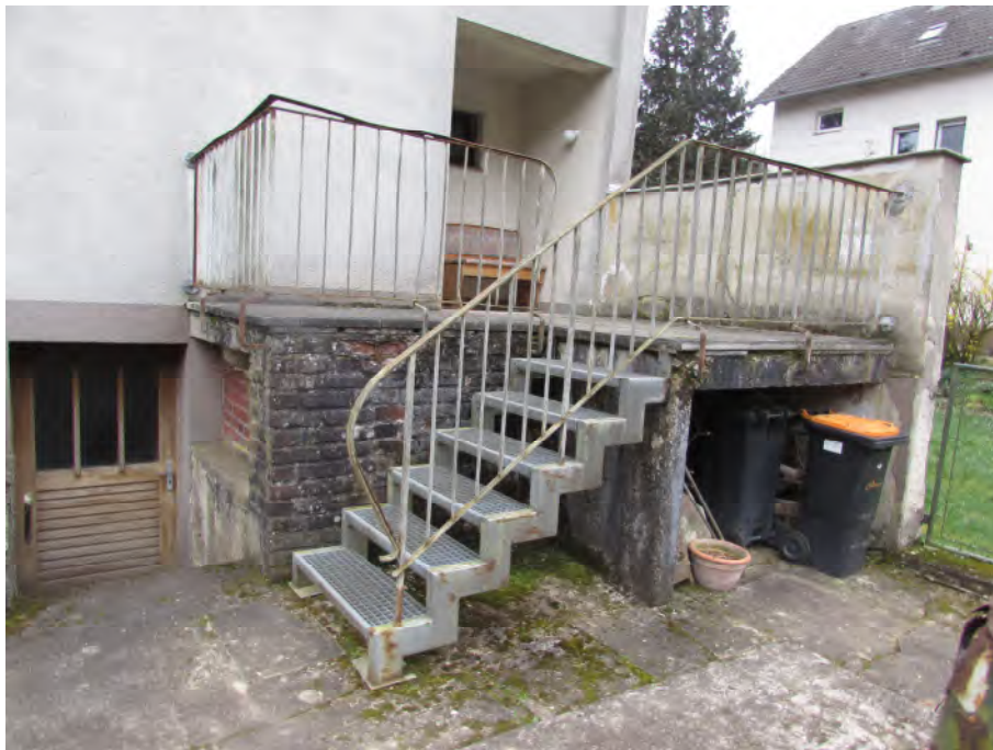
Foto 7: Loggia, Terrasse, Kelleraußentreppe
