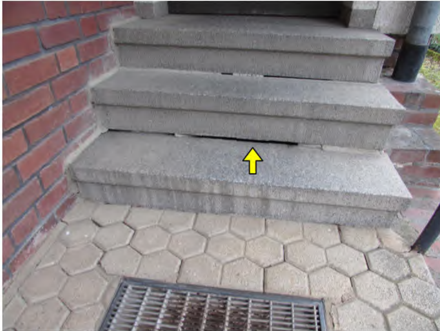
Foto 11: beschädigte Hauseingangstreppe
