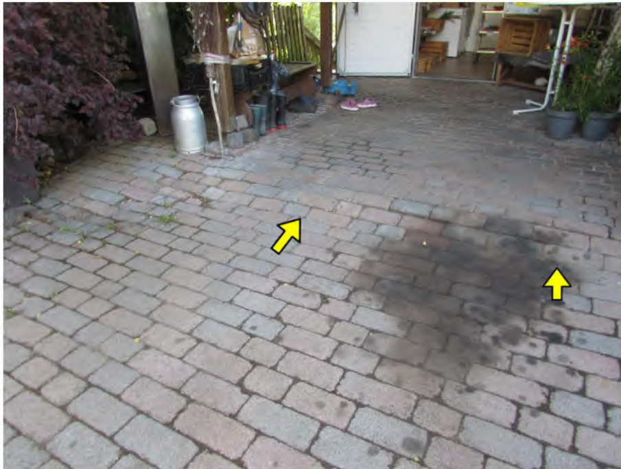
Foto 9: vordere Hofffläche, Zugang/Zufahrt: tlw. abgesetzte Befestigung
