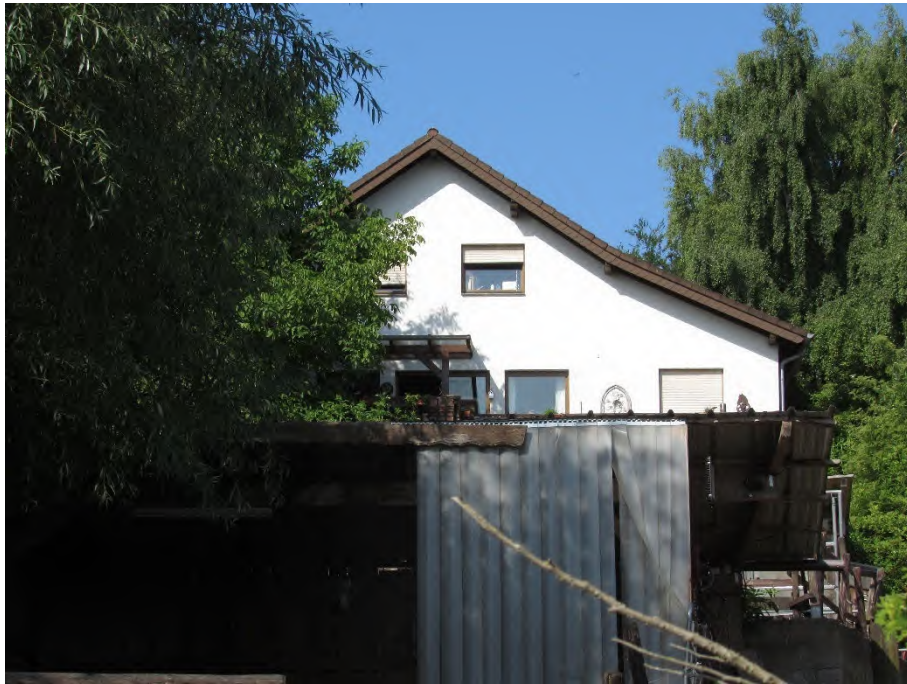
Foto 7: Wohnhaus, rückwärtige Ansicht
