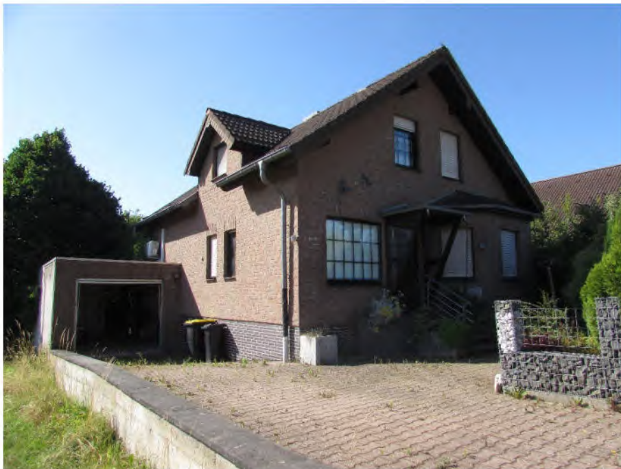
Foto 2: Wohnhaus mit PKW-Garage, Straßen-/Seitenansicht
