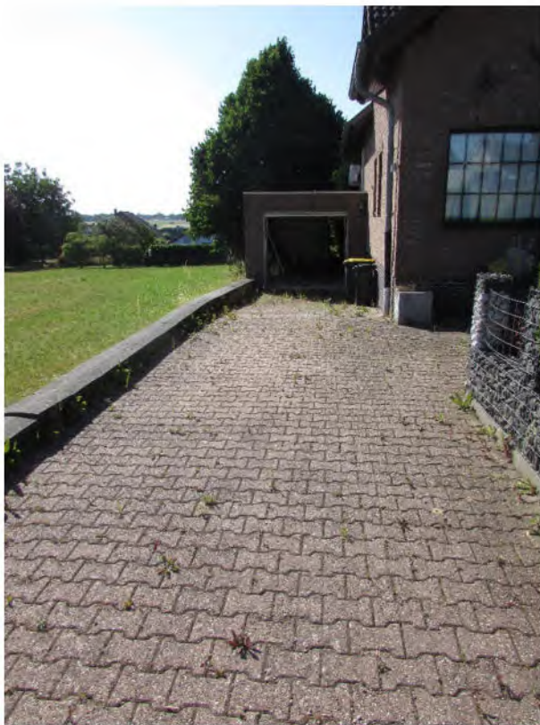
Foto 4: Wohnhaus mit PKW-Garage, Zufahrt
