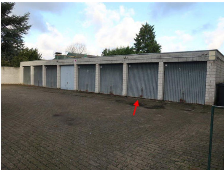
Bild 6 Ansicht Garagenhof mit Kennzeichnung Garage Nr. 6 (Teileigentum)
