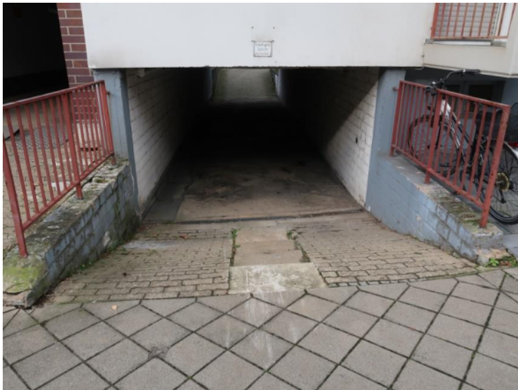
Bild 2 Zufahrt straßenseitig zum hin- terliegenden Garagenhof
