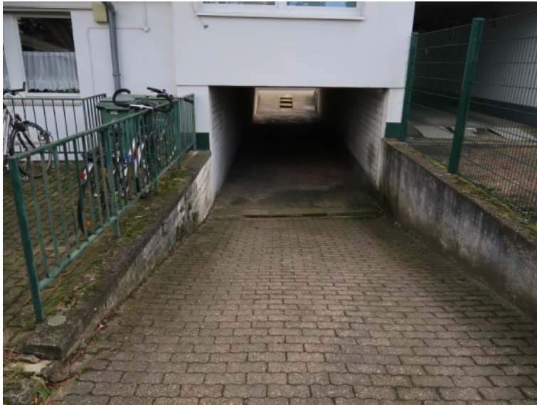
Bild 4 Zufahrt hofseitig zum hinterliegenden Garagenhof
