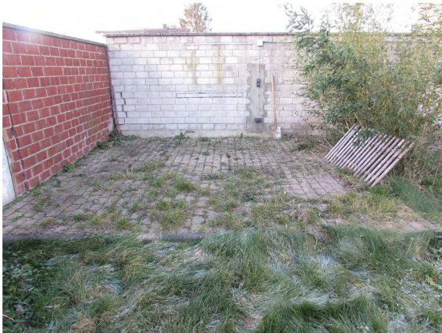
Foto 14: Freisitz im rückwärtigen Grundstücksbereich
