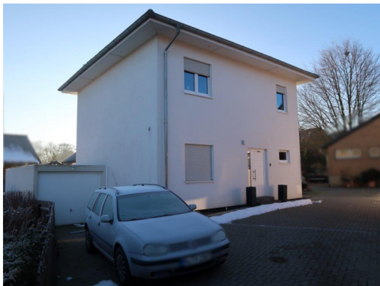
Bild 7 Außenansicht Haus Nr. 40a
