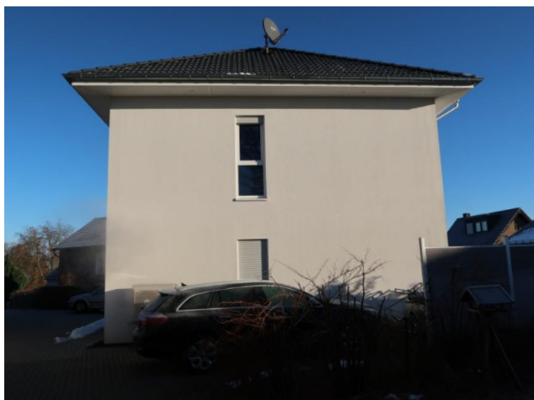
Bild 8 Außenansicht Haus Nr. 40a
