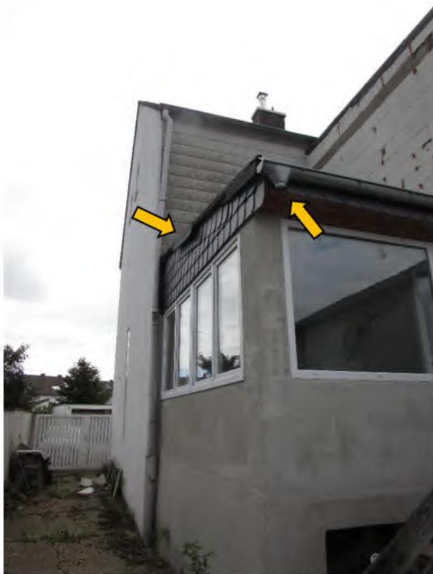
Foto 7: Wohnhaus, fehlendes Fallrohr, nicht ordnungsgemäß erstellter Dachabschluss, fleckige Fassade
