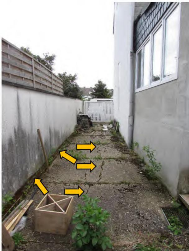
Foto 4: seitlicher Zugang, gerissener Betonboden, Feuchtigkeit an der Begrenzungsmauer
