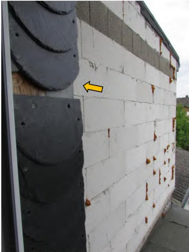
Foto 13: Wohnhaus, beschädigte Schieferverkleidung, fehlender Außenputz
