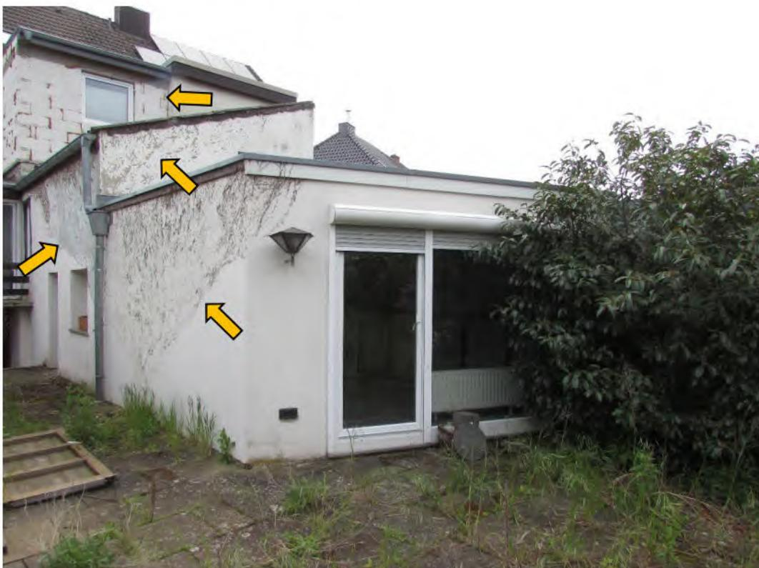
Foto 6: rückwärtige Anbauten, Rückansicht, Beschädigungen und Reste einer Begrünung an der Fassade
