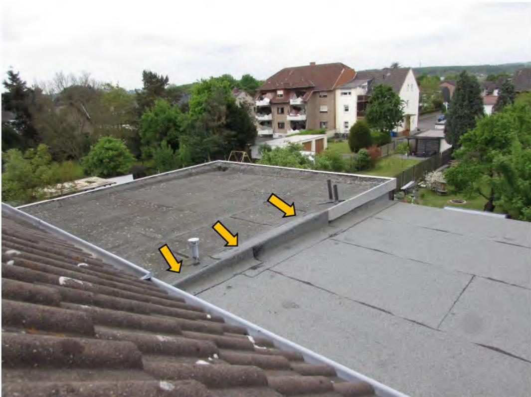
Foto 14: Wohnhaus, Flachdächer der Anbauten, Dachabschluss z.T. nicht ordnungsgemäß erstellt
