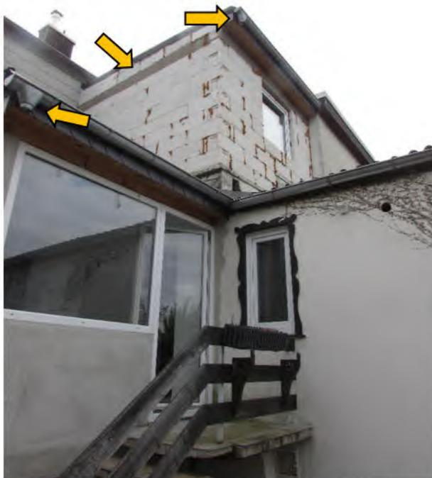
Foto 8: Wohnhaus, z.T. fehlender Außenputz, fehlende Fallrohre
