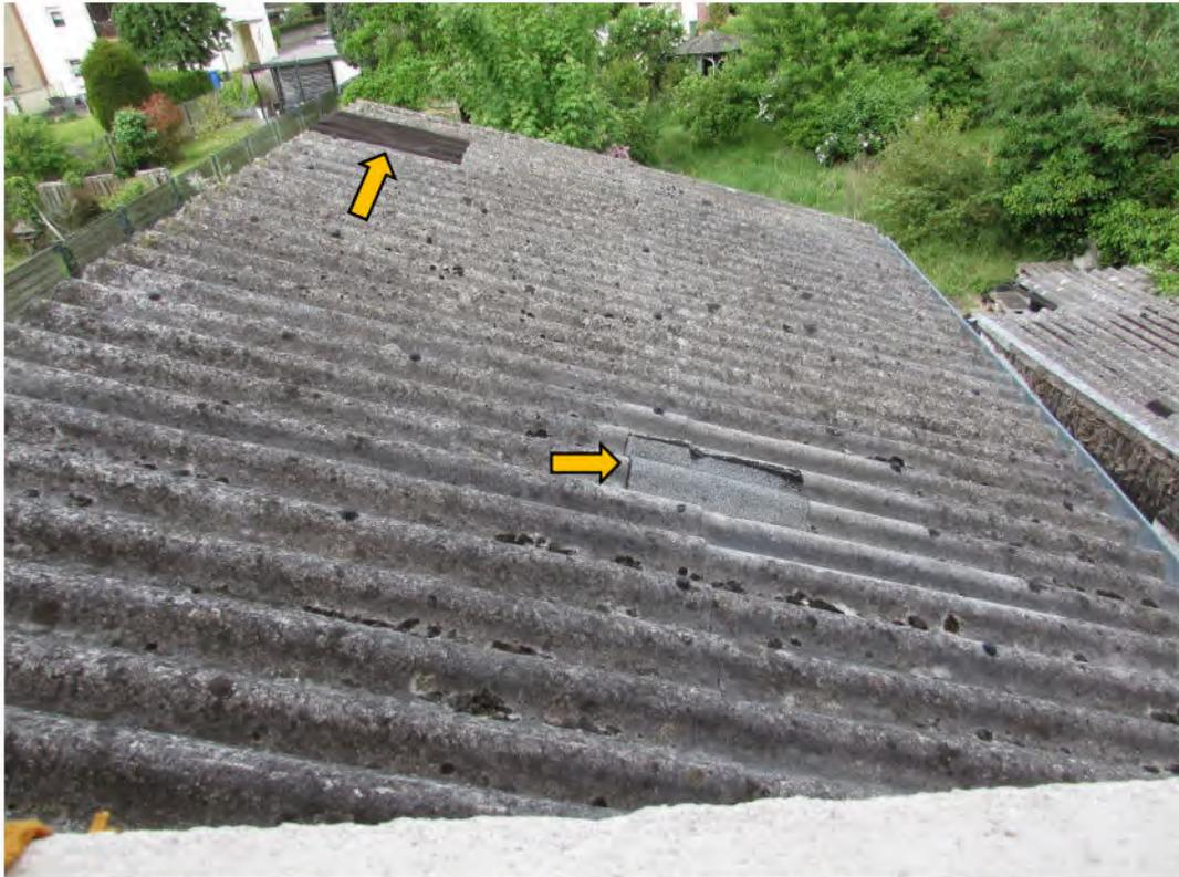
Foto 15: Wohnhaus, überalterte, z.T. beschädigte Dacheindeckung des Anbaus
