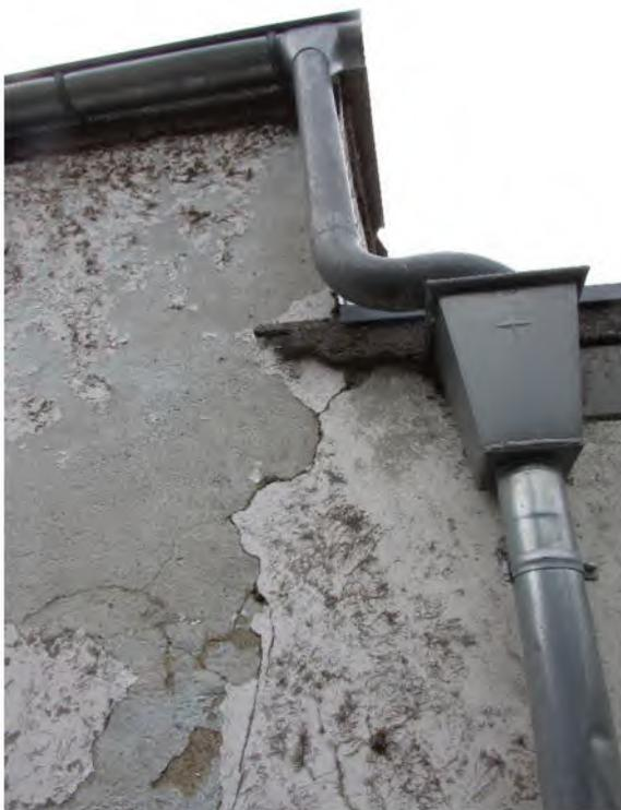
Foto 12: Wohnhaus, rückwärtige Anbauten, Risse und Beschädigungen an der Fassade
