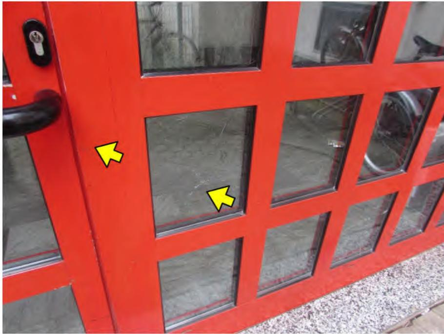
Foto 7: Hauseingangstürelement: verkratzte Lackierung und gerissene Fensterscheibe
