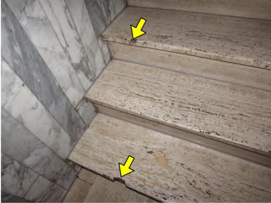
Foto 11: Treppenhaus/Geschosstreppe: beschädigter Travertinbodenbelag
