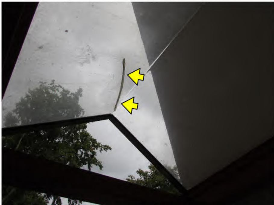
Foto 6: beschädigte Hauseingangsüberdachung
