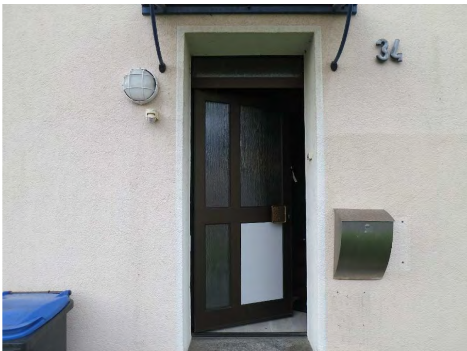
Lichtbild 4: Detail, Hauseingangstüranlage mit Glasbruchschaden und Reparaturfüllung
