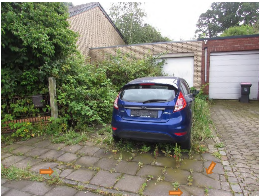
Foto 4: Zufahrt, beschädigte Betonplatten, verwilderte Eingrünung
