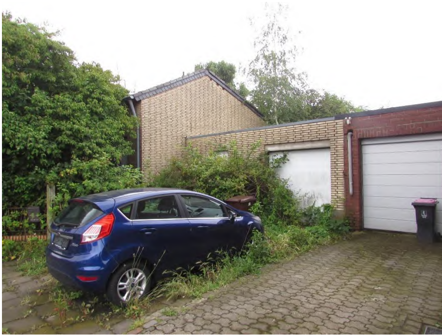
Foto 3: Wohnhaus mit PKW-Garage, Straßen-/Seitenansicht, verwilderte Eingrünung
