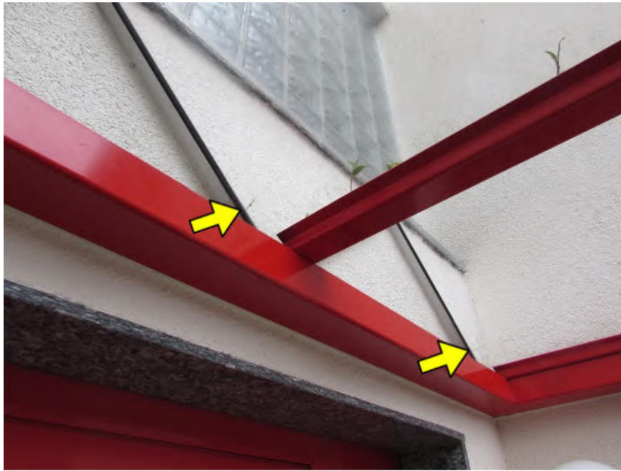
Foto 5: beschädigte Hauseingangsüberdachung
