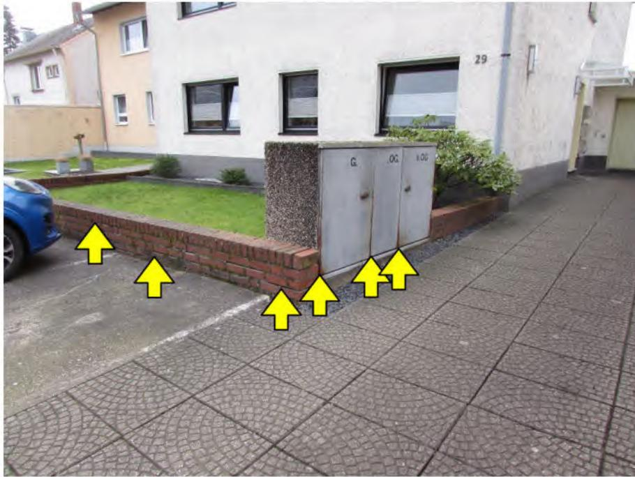
Foto 9: schadhafter Mauerwerkssockel, korrodierte Türen der Mülltonnenabstellbox
