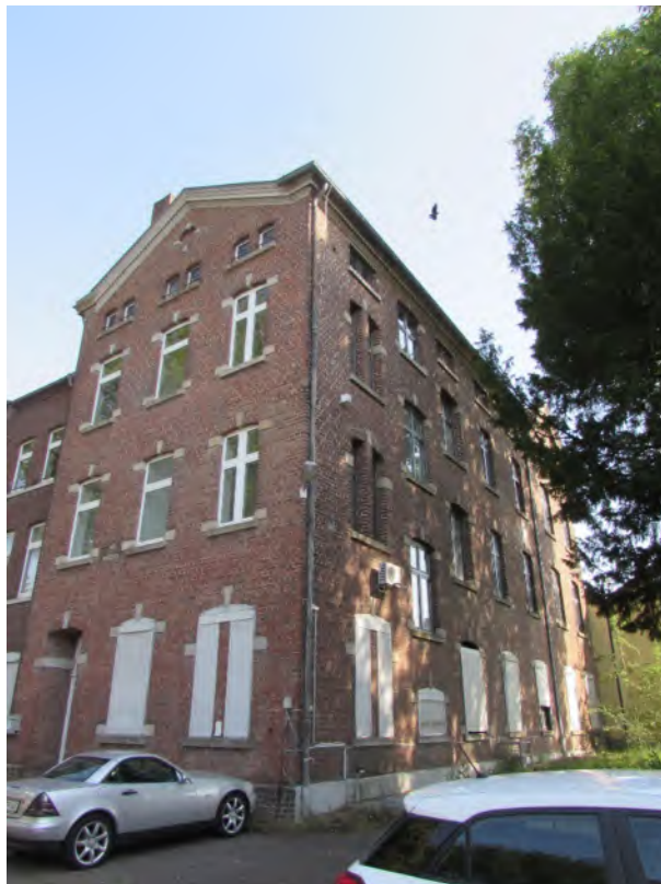
Foto 2: ehem. Klostergebäude, Südost-Ansicht
