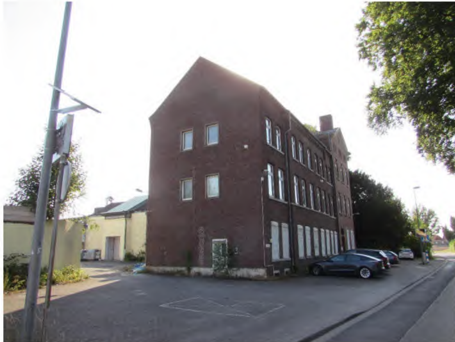
Foto 5: ehem. Klostergebäude, Südwest-Ansicht
