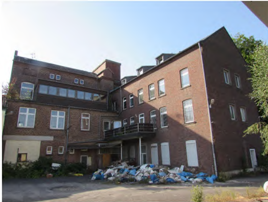
Foto 9: ehem. Klostergebäude, Unrat
