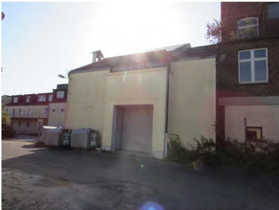
Foto 12: Lagerhalle (ehem. Kapelle), Südwest-Ansicht
