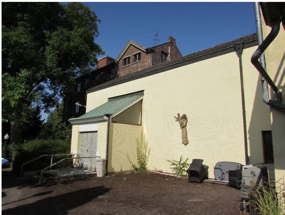
Foto 14: Lagerhalle (ehem. Kapelle), Nordost-Ansicht
