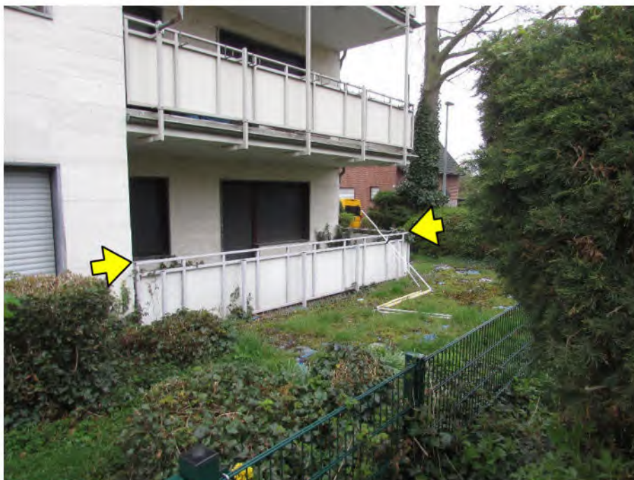
Foto 4: Wohnung Nr. 34, Terrasse 2, Süd-Ansicht
