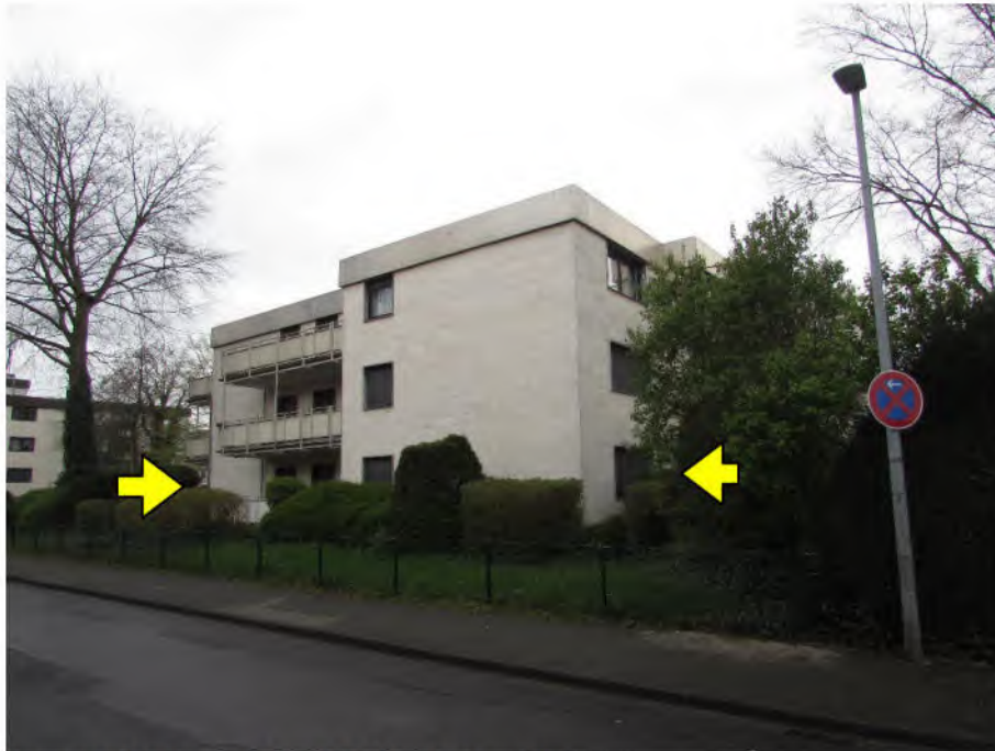
Foto 7: Wohnung Nr. 34, Nord-Ansicht
