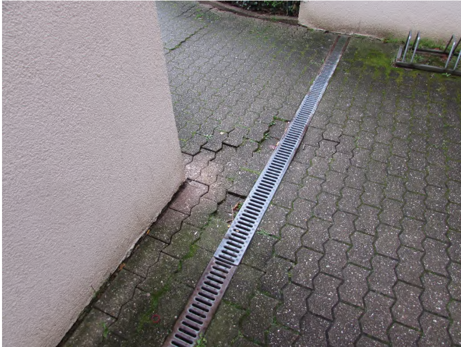
Foto 9: Zugang: abgesetzte Befestigung
