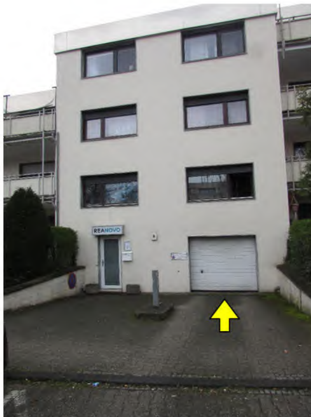
Foto 11: Zufahrt zur Tiefgarage "Im Wohnpark 4-6"
