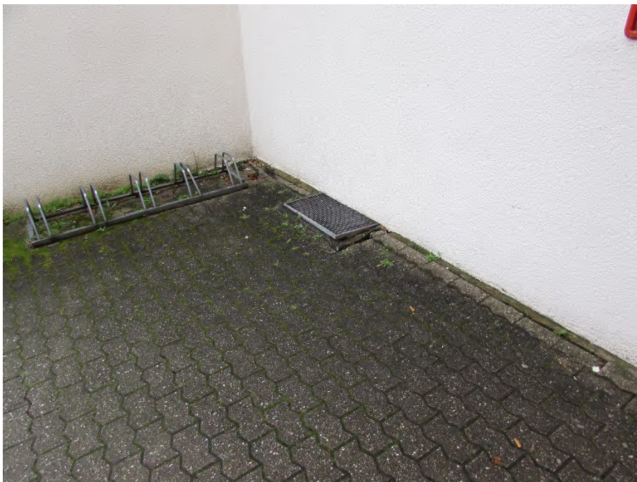
Foto 10: Zugang: abgesetzte Befestigung
