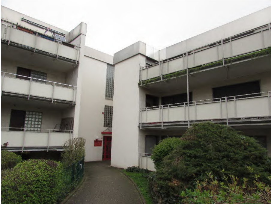
Foto 1: Mehrfamilienhaus "Im Wohnpark 6", Zugang, Hauseingang
