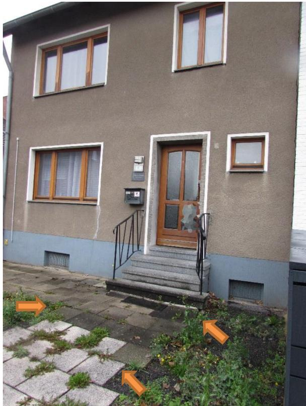
Foto 7: Wohnhaus, Hauseingang, abgesetzte Befestigungen, Risse in der Fassade
