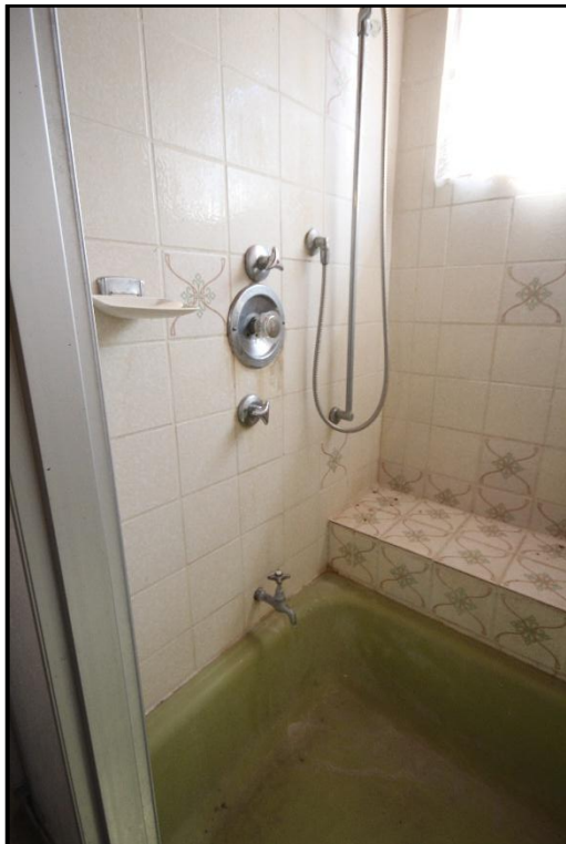
Bild 39: Dusche im Kellergeschoss
