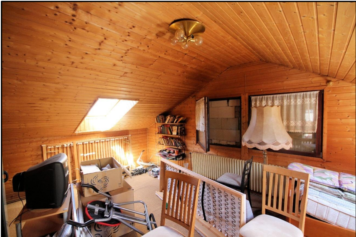
Bild 47: Dachgeschossraum an der nördlichen Giebelwand zum Wohnungseigentum Nr. 2 (siehe Mauerwerk im geöffneten Giebelfenster)
