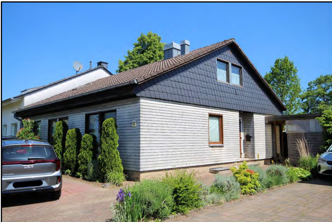
Bild 4: Ansicht von Süden
