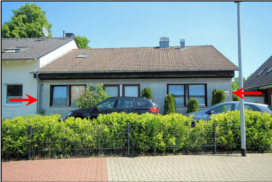
Bild 3: Ansicht von Westen
