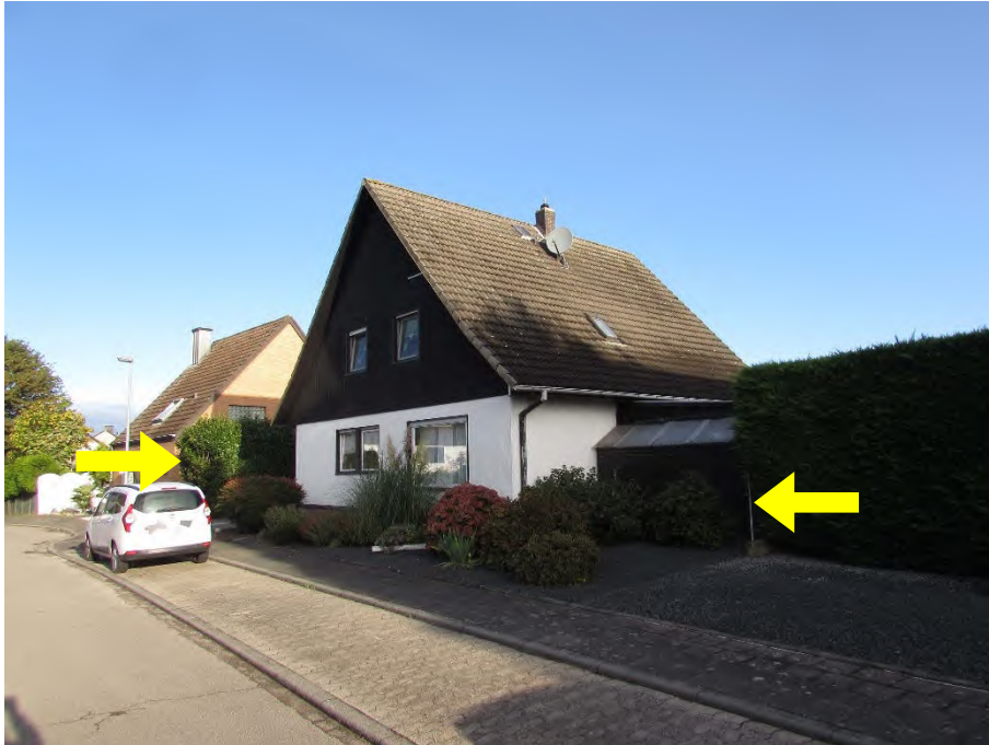
Foto 1: Wohnhaus "Morkener Straße XX", 50181 Bedburg-Kaster, Straßenansicht
