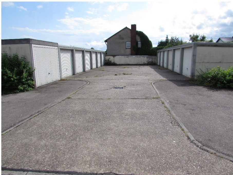
Foto 10: Flurstücke 772, 819, 820, 818, 821, 771, 817, 822 und 823: Garagenhof, Ansicht von der "Beethovenstraße"
