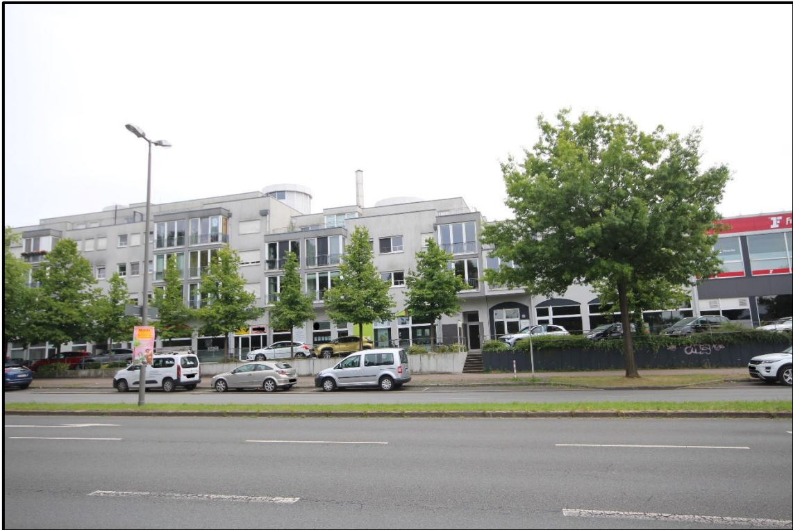
Bild 3: Gesamtansicht von Nordwesten
