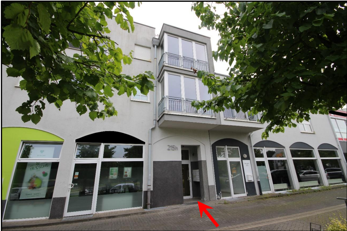
Bild 1: Eingang zu den Wohneinheiten Bergstraße 215 h
