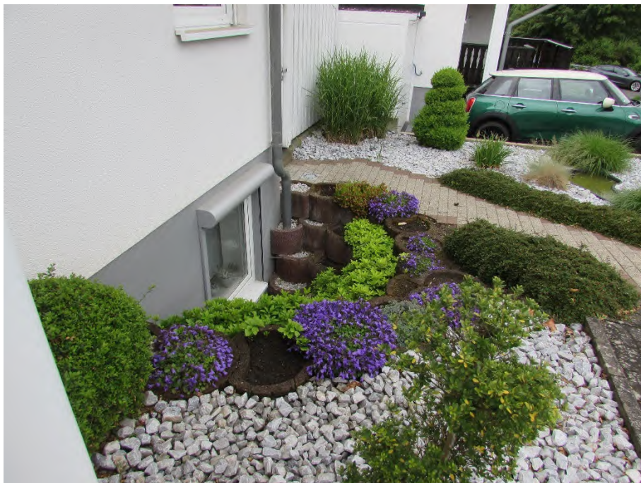
Foto 2: abgeböschtes Gelände/Lichtschacht vor dem Hobbykeller
