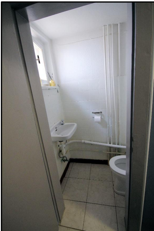
Bild 17: WC der Gewerbeeinheit im Treppenhaus im Erdgeschoss
