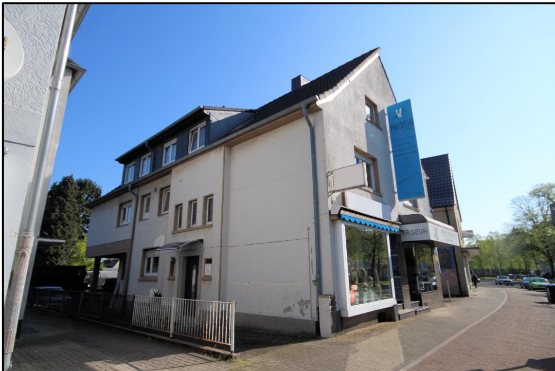
Bild 6: Ostseite des Gebäudes
