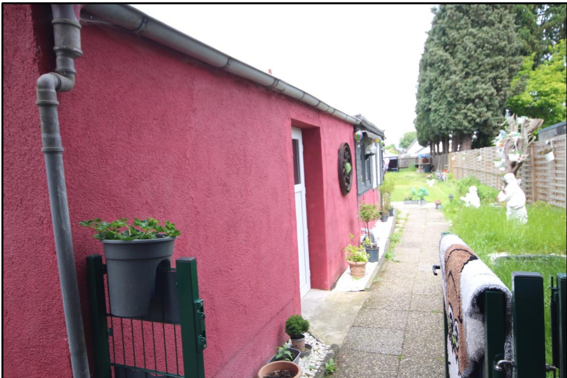
Bild 11: Garage und Gerätehaus
