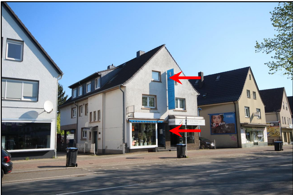
Bild 2: Ansicht von Südwesten
