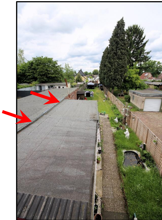
Bild 14: Blick vom Balkon auf die Dachflächen der Garage und des Gartenhauses
