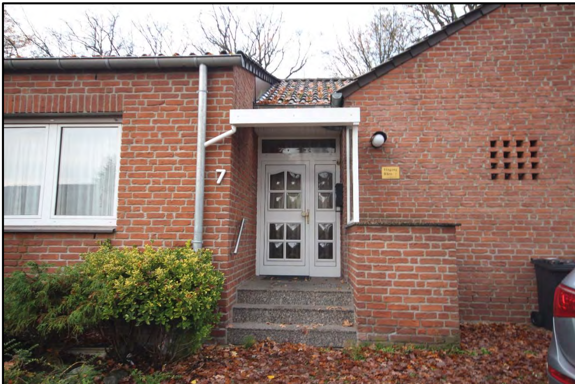
Bild 4: Hauseingang an der Ostseite
