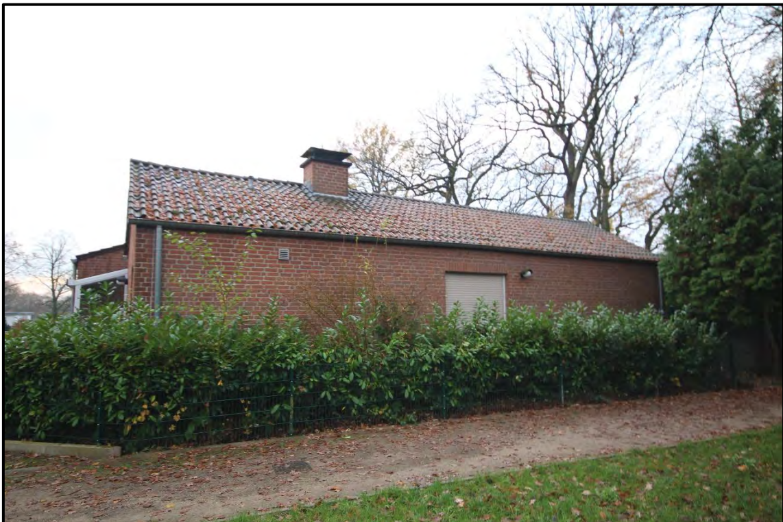
Bild 8: Ansicht von Norden
