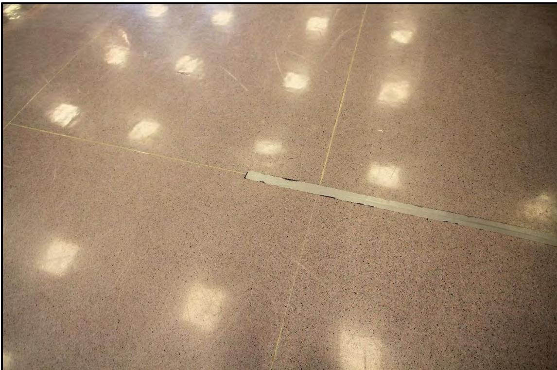
Bild 21: Schäden am Oberbodenbelag des Saales
