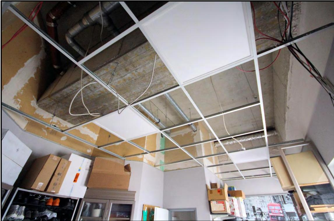
Bild 10: erneuerungsbedürftige Rasterdecke im Büro (Aufgrund von Rohrleitungsschäden entfernt)
