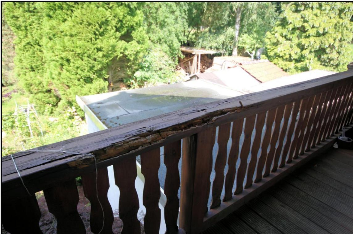
Bild 25: geschädigte Balkonbrüstung im Dachgeschoss der Hauptwohnung
