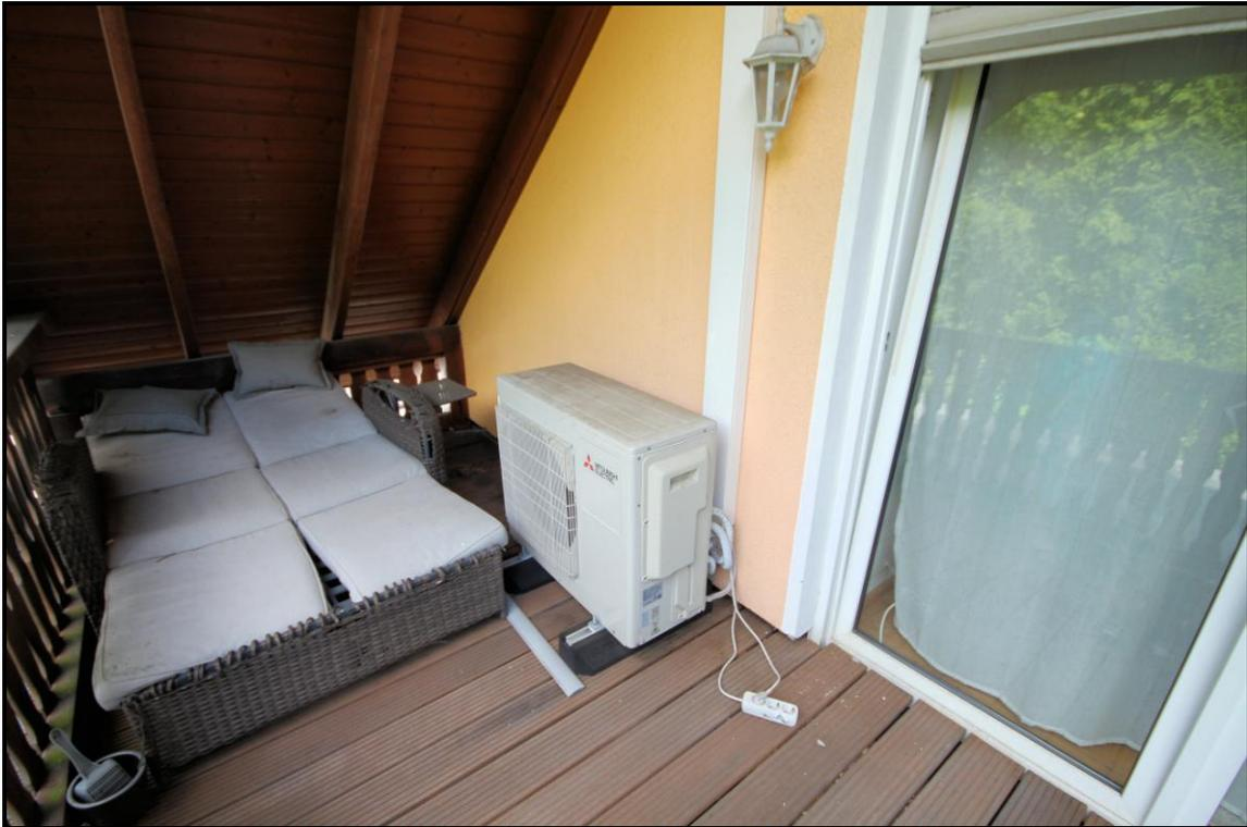
Bild 26: Klimasplittgerät auf dem Balkon im Dachgeschoss der Hauptwohnung
