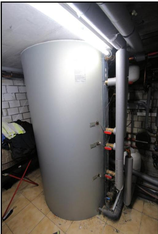
Bild 19: erster Warmwasserspeicher im Kellergeschoss
