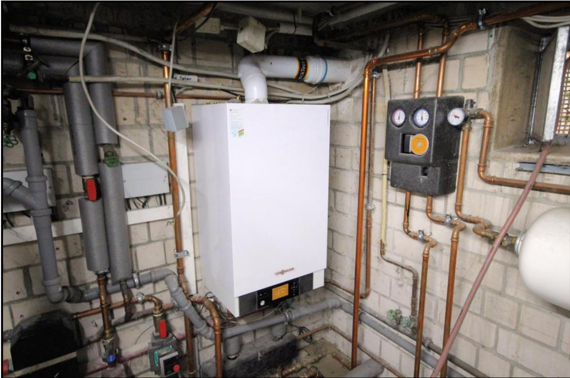
Bild 18: Gas- Brennwerttherme im Kellergeschoss
