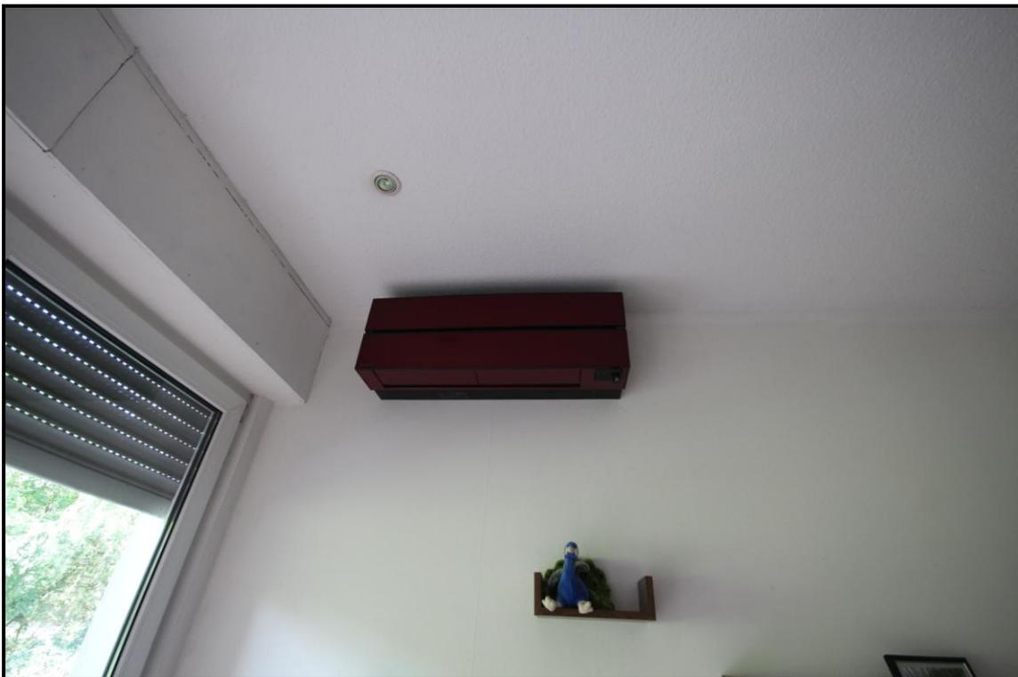
Bild 29: Klimasplittgerät im Raum Schlafen im Dachgeschoss der Hauptwohnung
