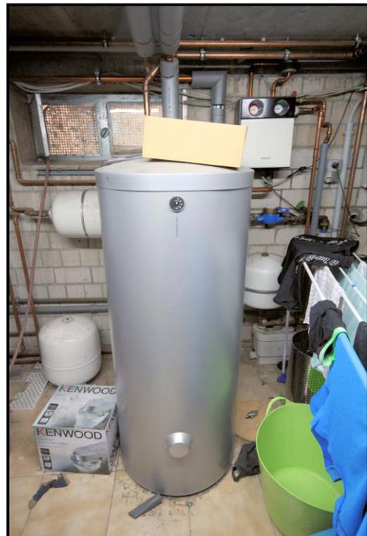
Bild 20: zweiter Warmwasserspeicher im Kellergeschoss
