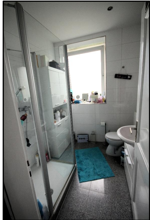
Bild 24: Dusche/WC der Wohneinheit 1 im EG links
