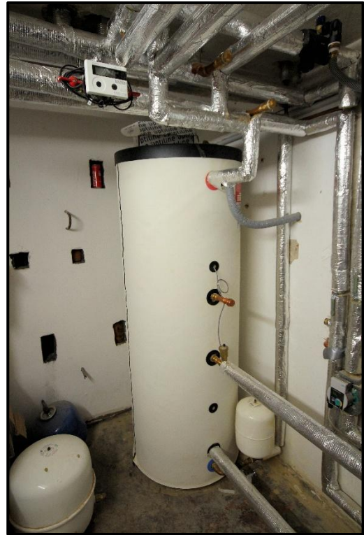
Bild 18: Warmwasserspeicher im KG
