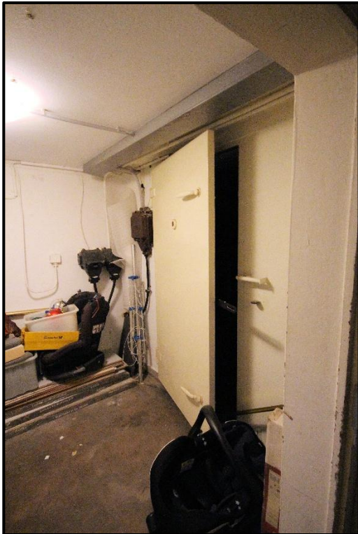
Bild 20: ehemaliger Schutzraum mit Stahltür im KG
