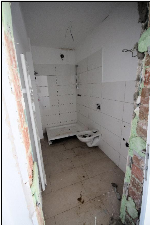
Bild 25: teilweise demontiertes Bad der WE Nr. 7
