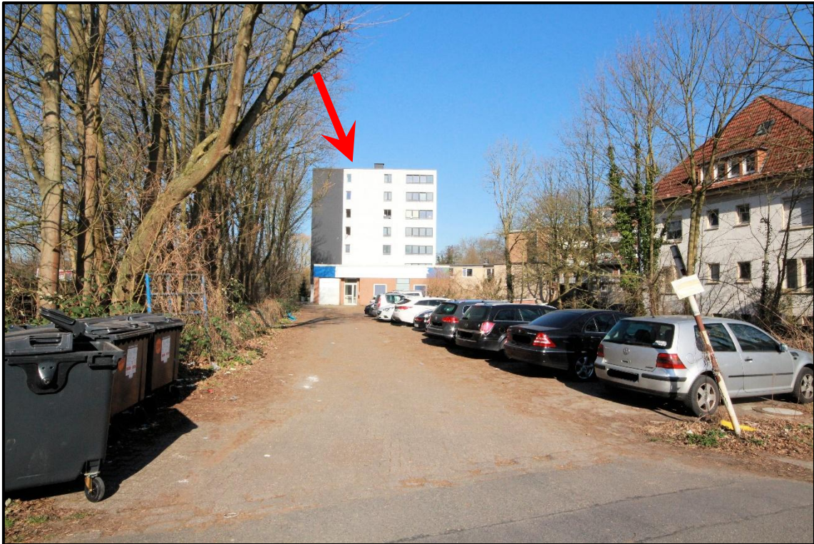
Bild 1: Ansicht von Südosten (Stellplatzreihe)
