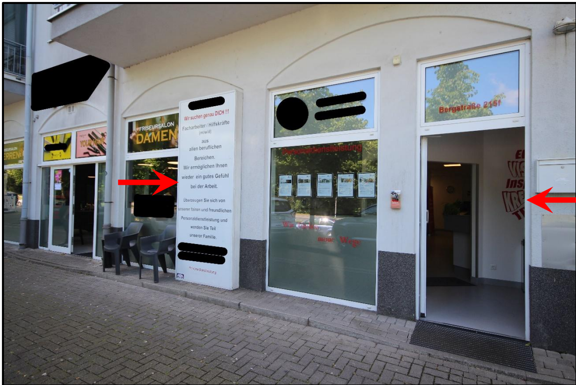
Bild 3: Ansicht von Nordosten
