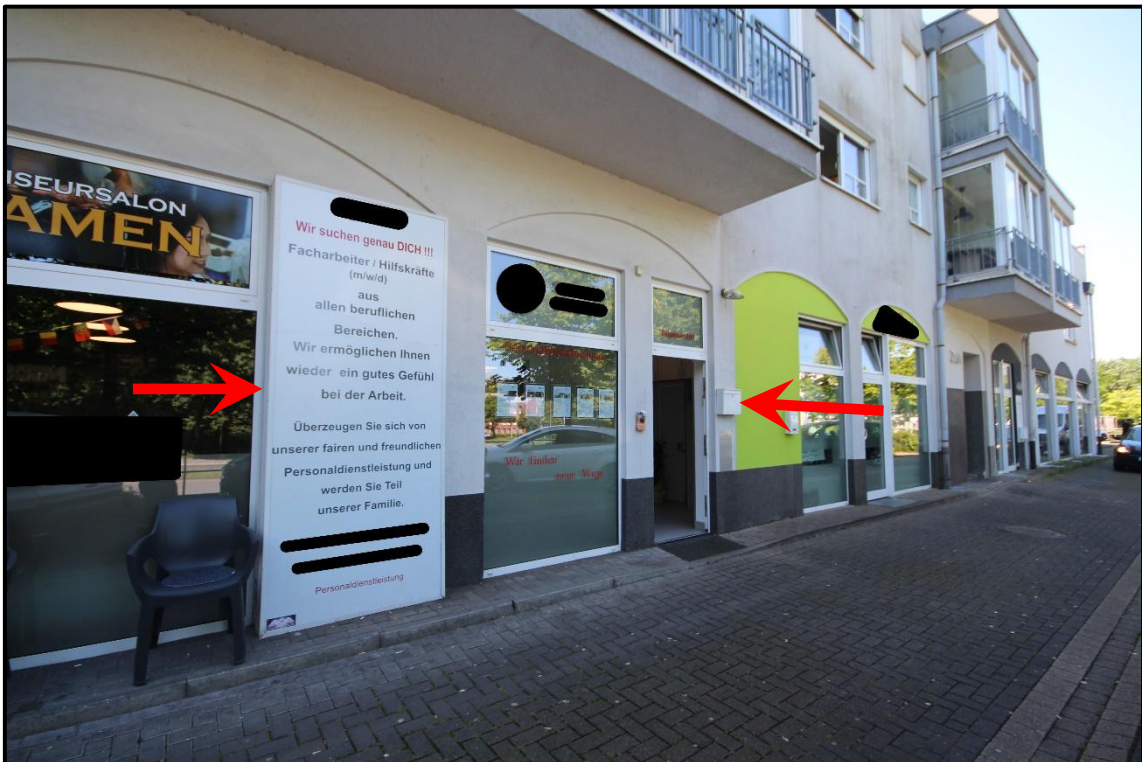
Bild 2: Ansicht von Norden
