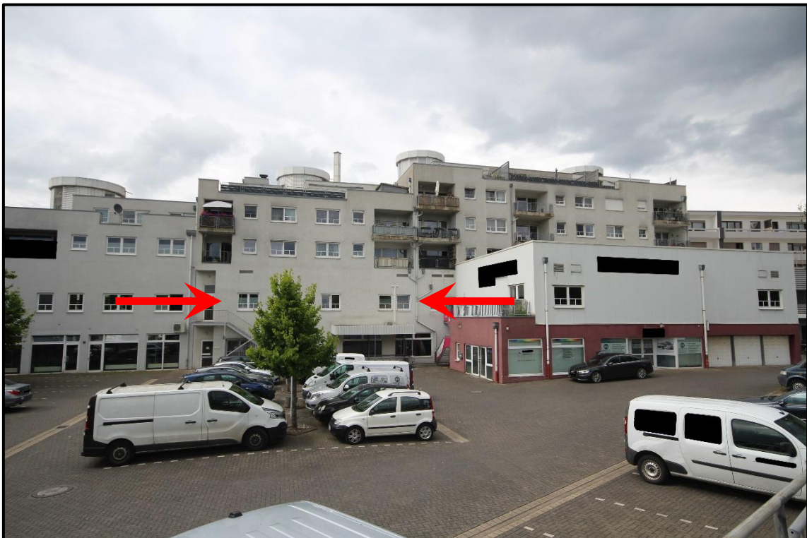
Bild 6: Ansicht von Süden
