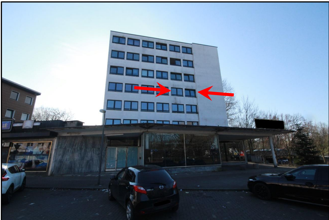
Bild 6: Ansicht von Norden
