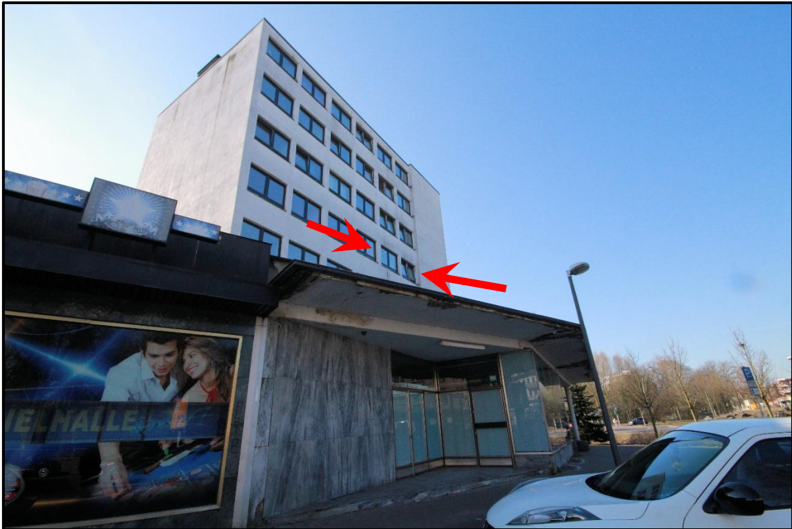
Bild 7: Ansicht von Nordosten
