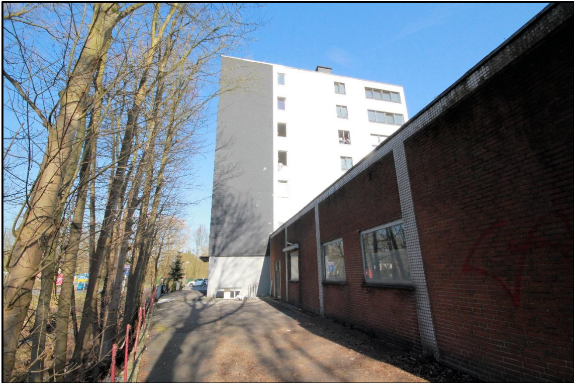
Bild 3: seitlicher Weg zum Hauseingang an der Westseite
