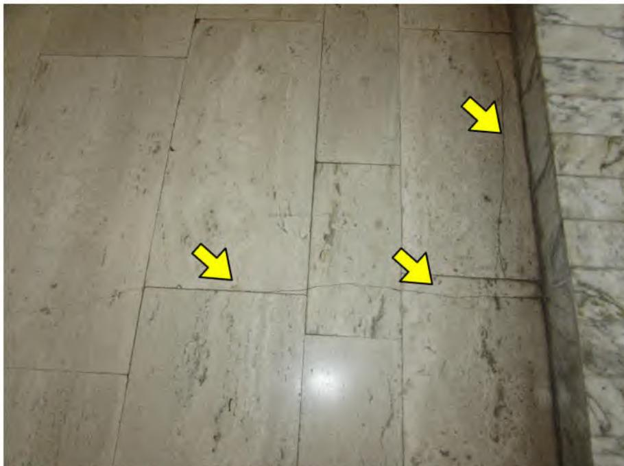
Foto 8: Treppenhausflur: beschädigter Travertinbodenbelag
