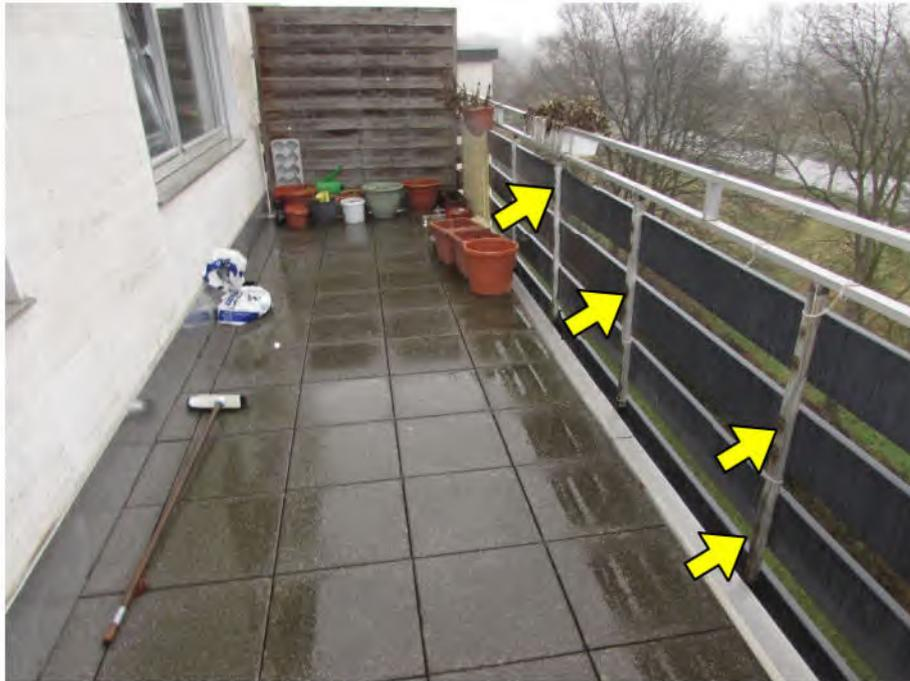
Foto 11: Balkon, mit Ausblick zur Erft: korrodiertes Geländer, überalterte Kunststoffausfachung
