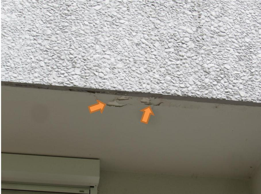
Foto 17: Wohnhaus, Feuchtigkeit und Beschädigungen an der Untersicht der Balkone (exemplarisch)
