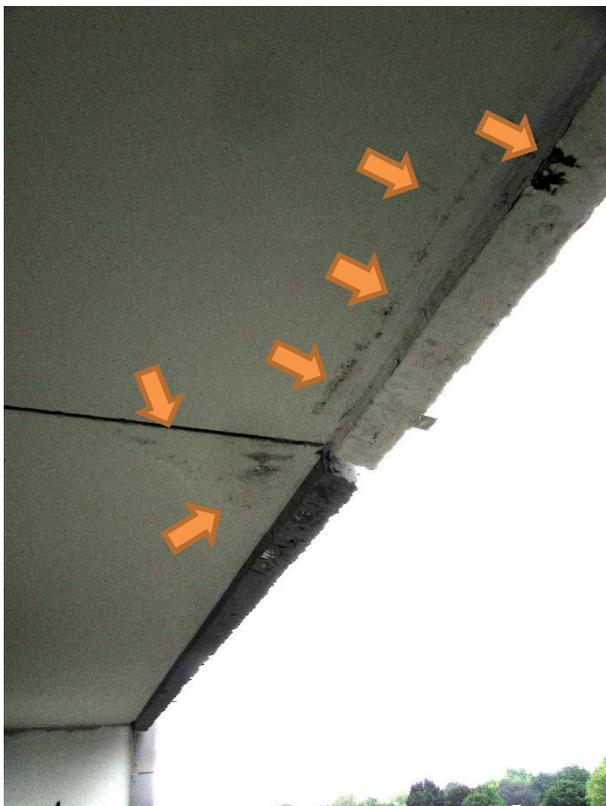
Foto 16: Wohnhaus, Feuchtigkeit und Beschädigungen an der
