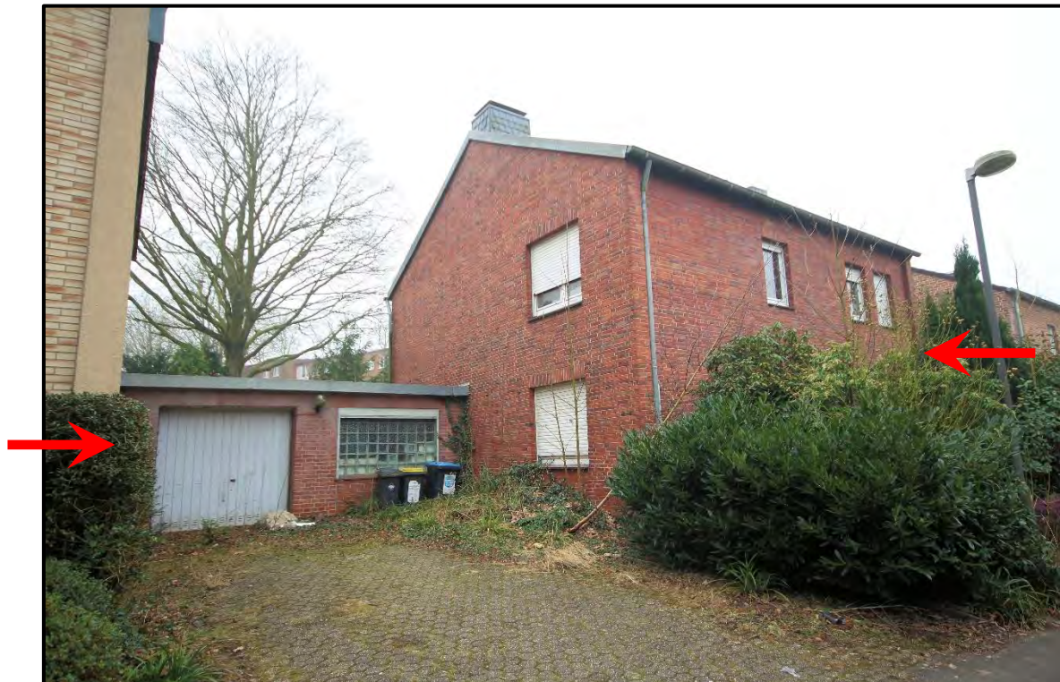
Bild 8: Ansicht von Osten (Bild vom 11.03.2025)
