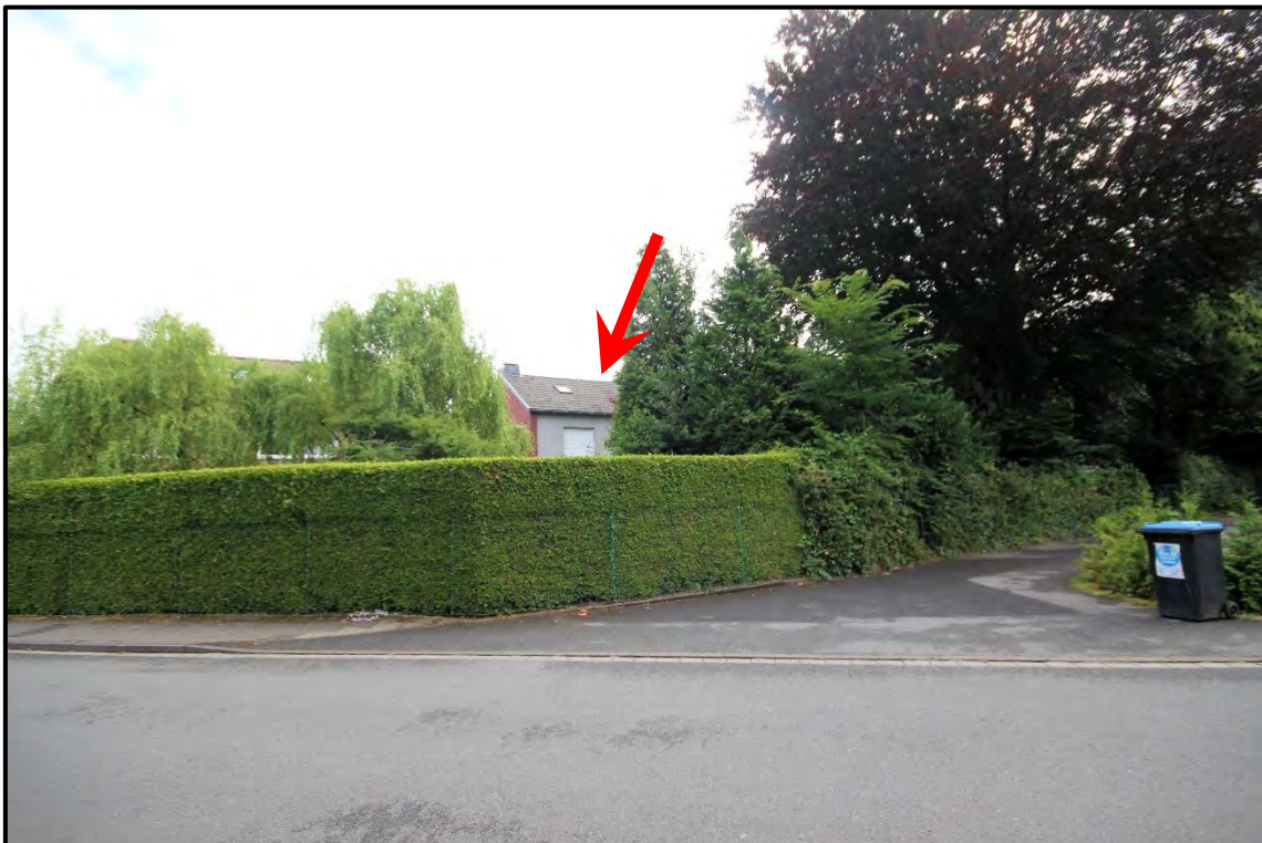
Bild 12: Ansicht von Südwesten (Bild vom 09.07.2025)
