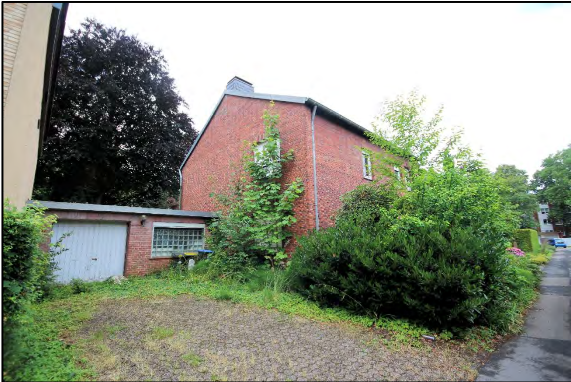
Bild 9: Ansicht von Osten (Bild vom 09.07.2025)
