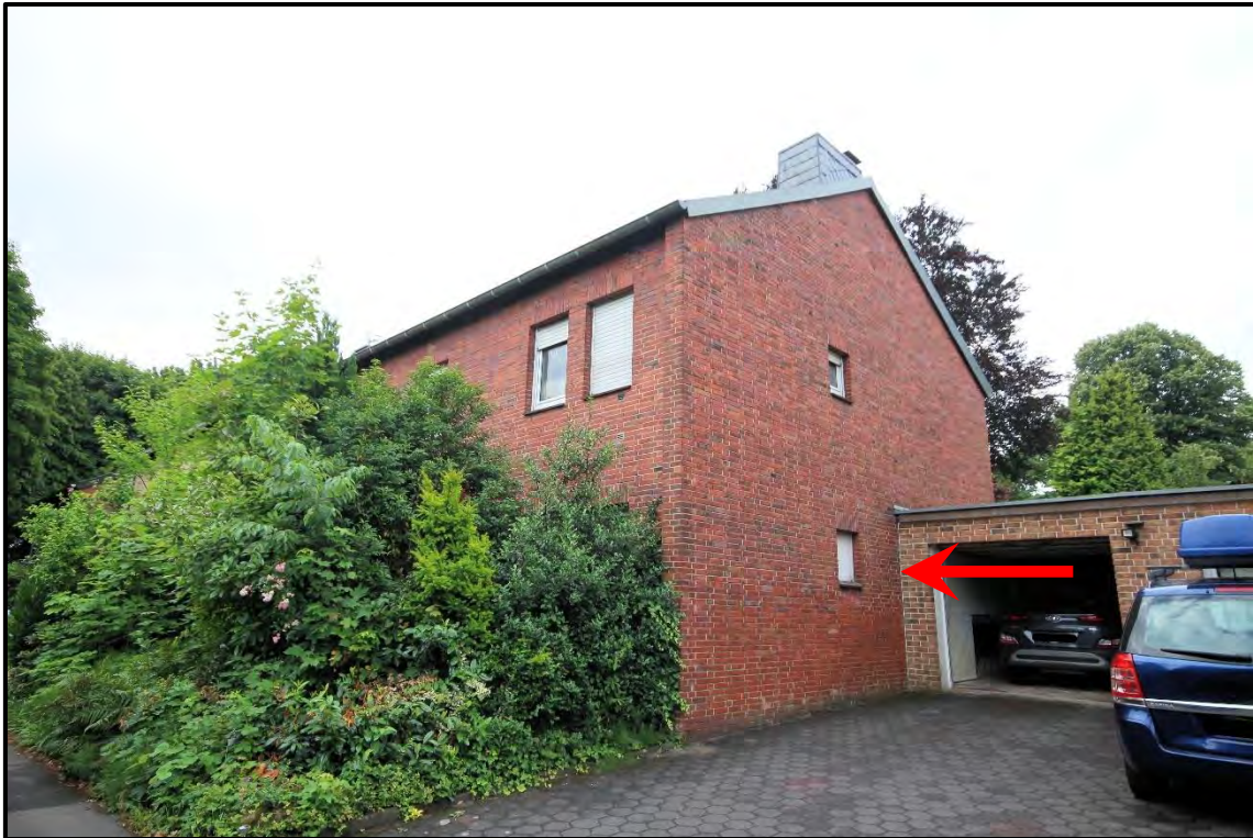
Bild 3: Ansicht von Norden (Bild vom 09.07.2025)
