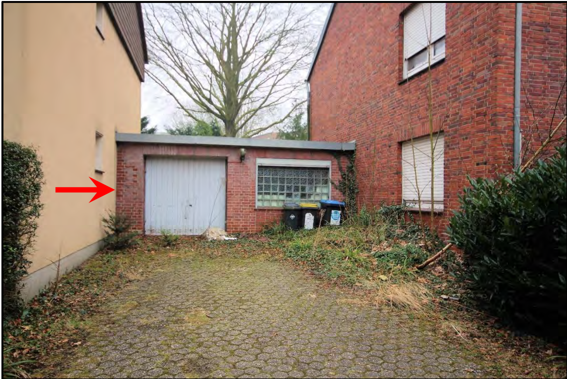
Bild 7: zugehöriges Nebengebäude (Bild vom 11.03.2025)
