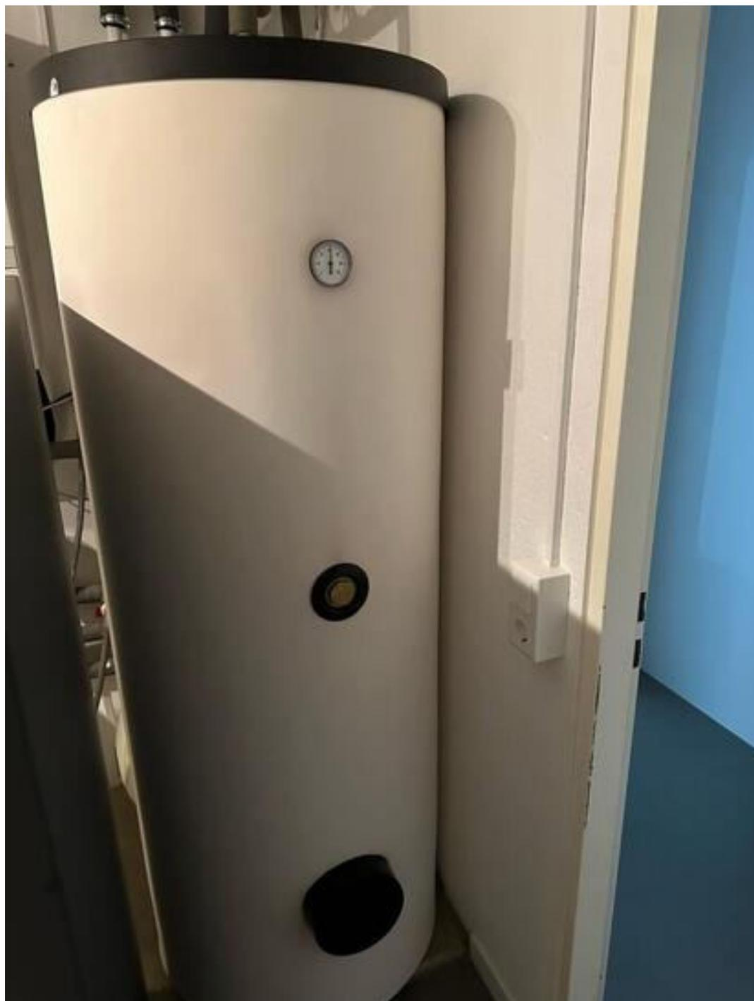
Bild 17 - Warmwasserspeicher
