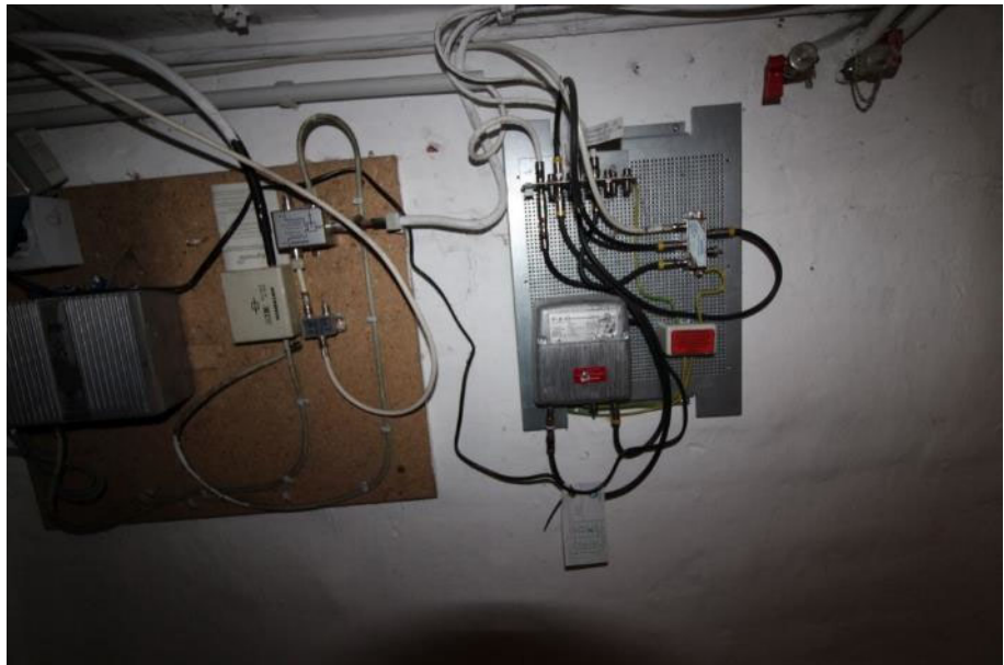
Sicht auf die Kabelan- schlussverteiler im Flur / KG.
