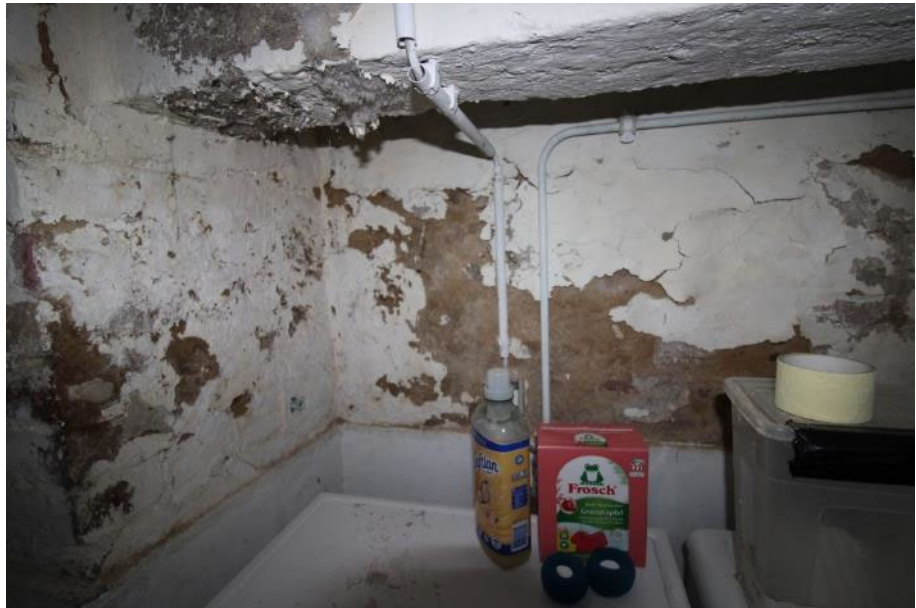
Sicht auf Feuchteschäden am Kellermauerwerk / KG.
