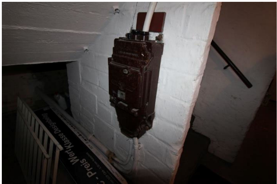
Sicht auf den Hauptstromanschluss im Flur / EG.
