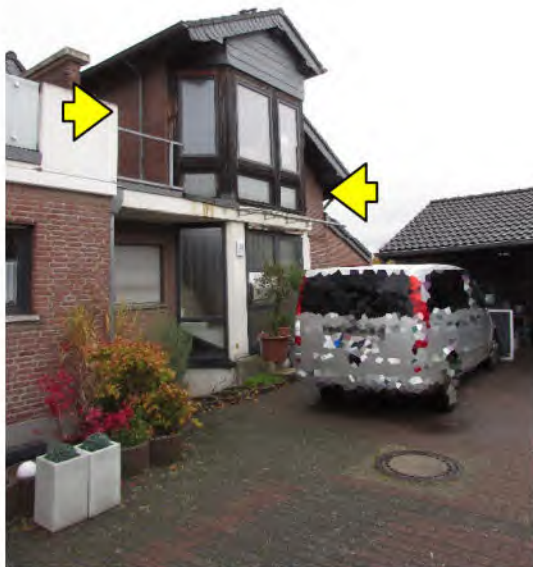
Foto 1: Flurstück 903: Eigentumswohnung Nr. 2 im Dachgeschoss des Zweifamilienhauses "Am Brölskamp XX", 50259 Pulheim-Stommeln
