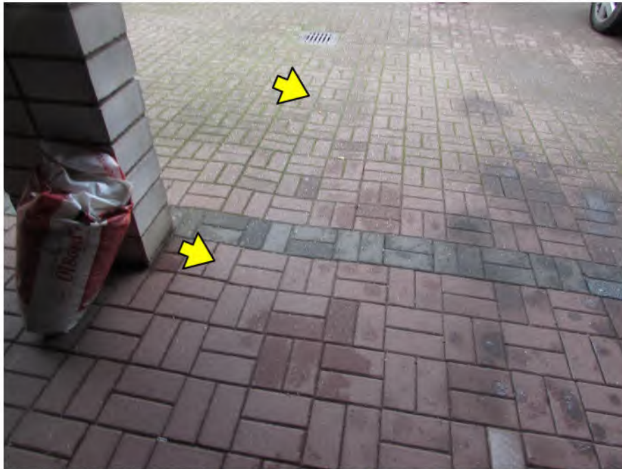
Foto 15: Privatstraße (Flurstück 915) und Carport (Flurstück 903): abgesetzte Befestigung
