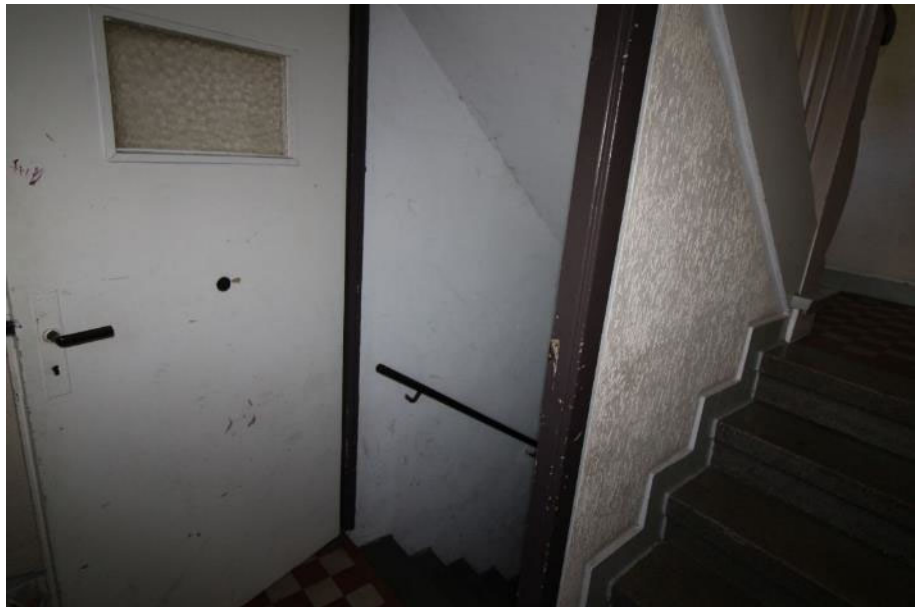
Sicht in das Treppenhaus / EG.
