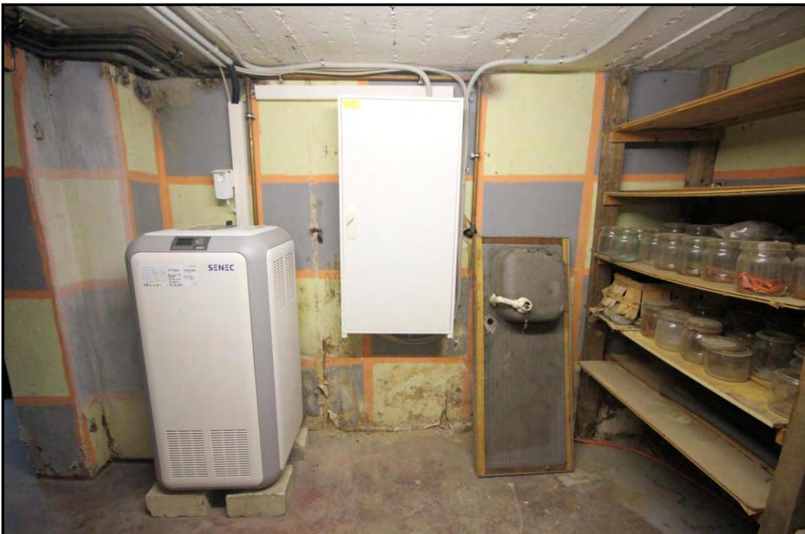
Bild 22: Steuer- und Zentraleinheit der PV-Anlage des Wohnungseigentums Nr. 2 im ehemaligen Heizungskeller im Kellergeschoss des Altbaus
