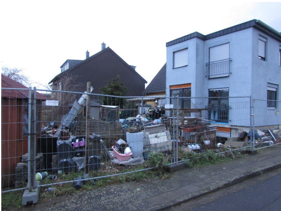
Foto 12: Wohnhaus (Anbau), Straßen-/Rückansicht, Baumaterialien und Unrat
