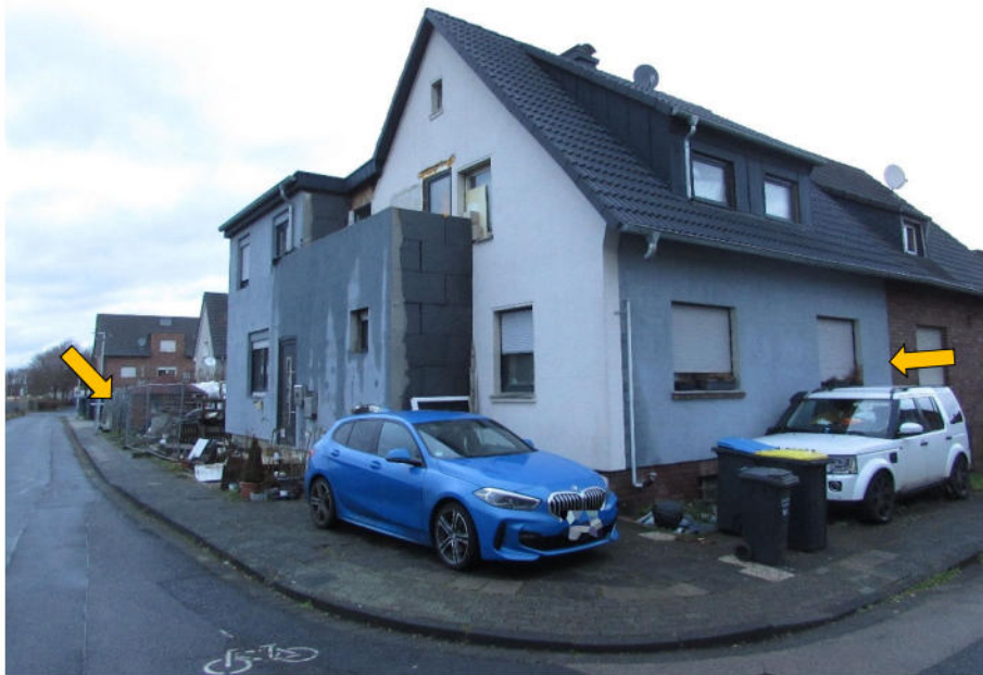
Foto 1: Straßenecke "Martin-Vetten-Straße", Wohnhaus, Straßen-/ Seitenansicht
