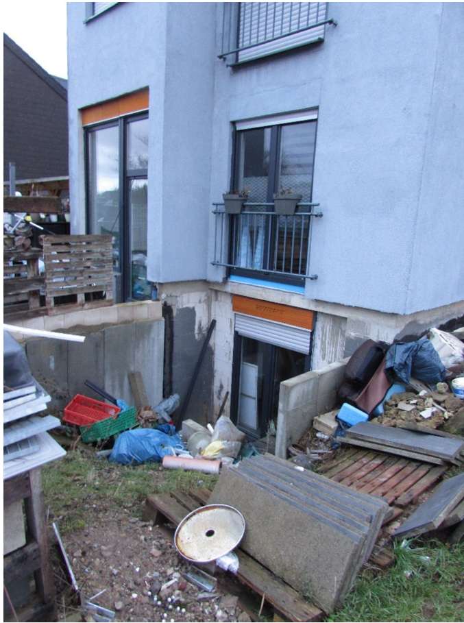
Foto 11: Wohnhaus (Anbau), Kellergeschoss z.T. offen erstellt
