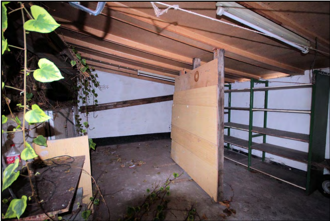
Bild 47: überdachter Bereich des Nebengebäudes
