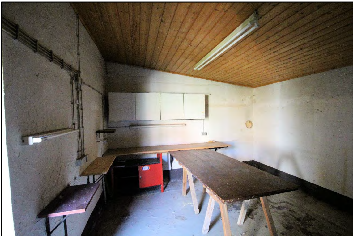
Bild 46: Abstellraum 3 im Nebengebäude
