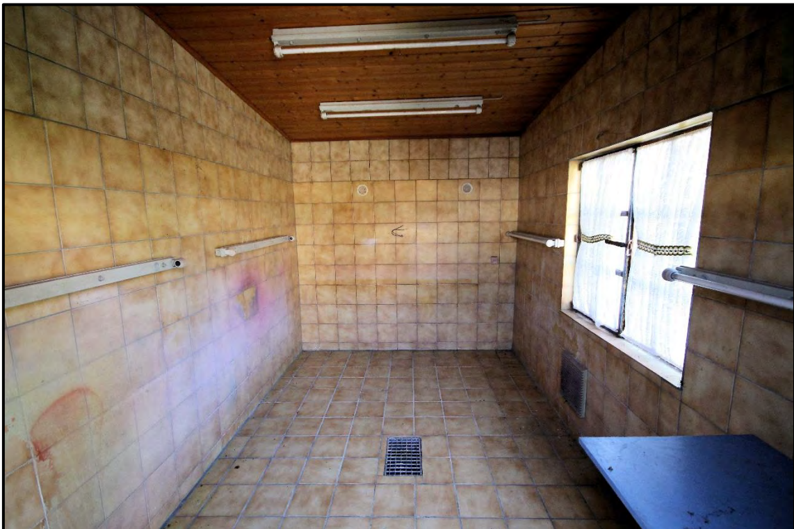
Bild 44: Abstellraum 1 im Nebengebäude
