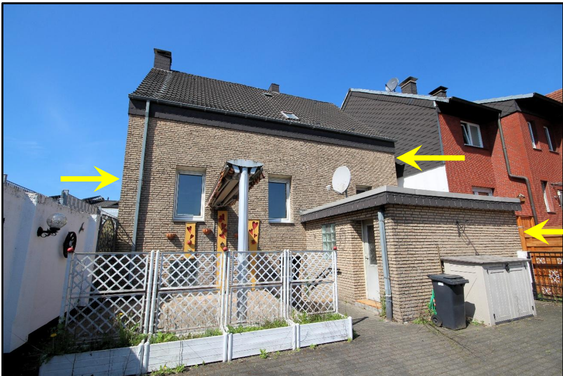
Bild 6: Ansicht von Osten
