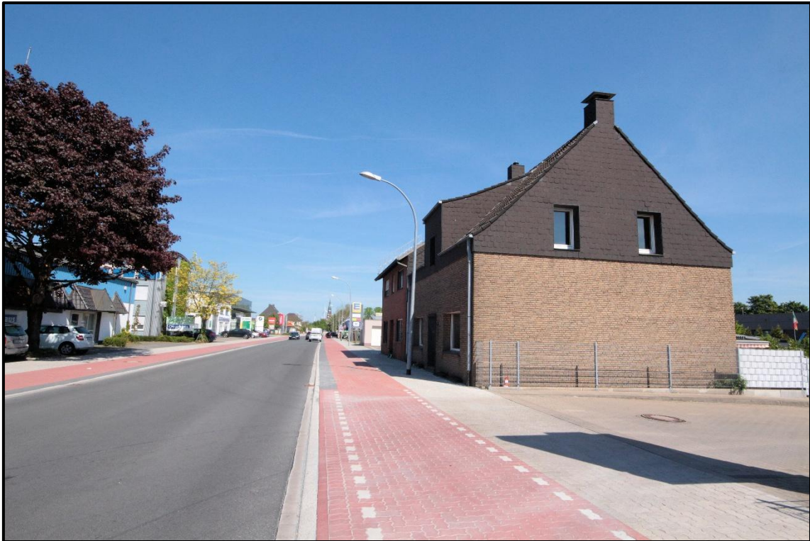
Bild 5: Blick in die Recklinghäuser Straße nach Norden
