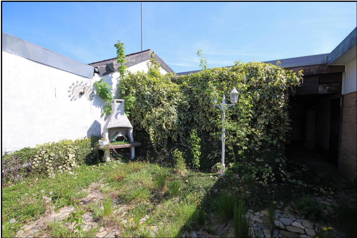
Bild 11: Nebengebäude an der östlichen Grundstücksgrenze
