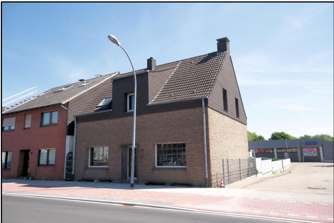
Bild 4: Ansicht von Südwesten
