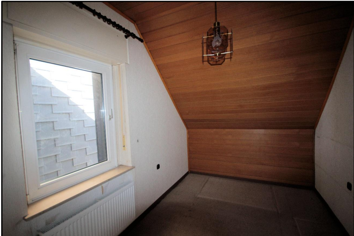
Bild 26: Kind I im DG hinten links, Gartenseite
