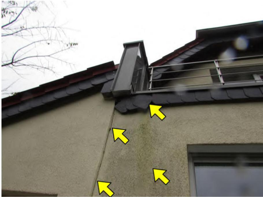
Foto 7: Wohnhaus: lose Faserzementplatten der seitlichen Dachabschlussverkleidung, fleckige Putzfassade, aufgerissene Anschlussfuge zur angrenzenden Garage
