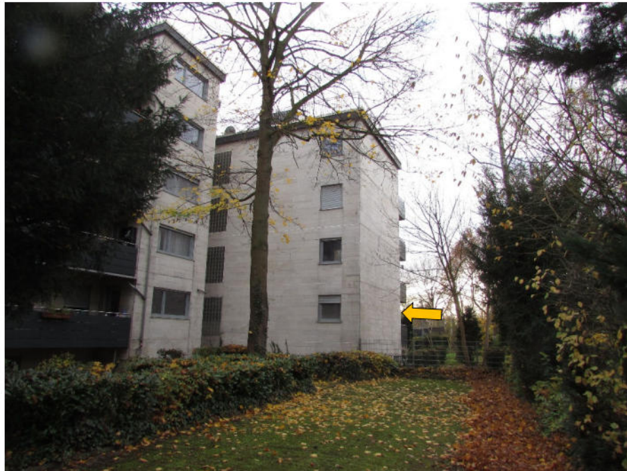
Foto 3: Wohnhaus, Rückansicht, Wohnung Nr. 2 im Erdgeschoss
