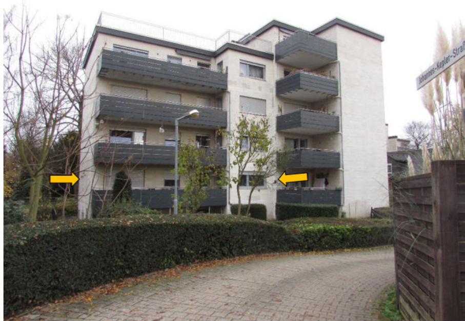
Foto 1: Privatstraße "Johannes-Kepler-Straße", Wohnhaus mit Wohnung Nr. 2 im Erdgeschoss
