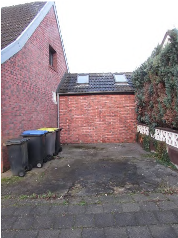
Foto 4: Anbau I und PKW - Stellplatz
