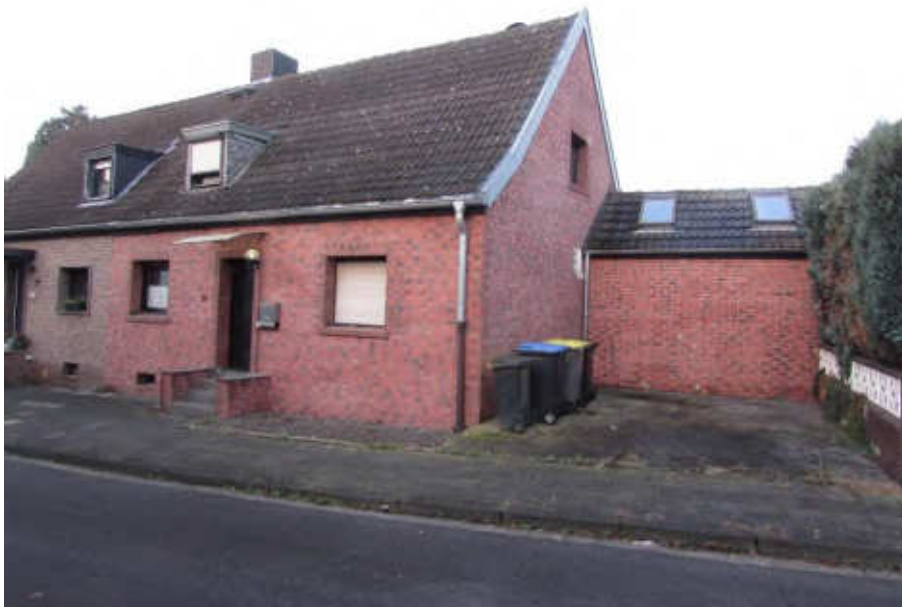
Foto 2: Wohnhaus und Anbau I
