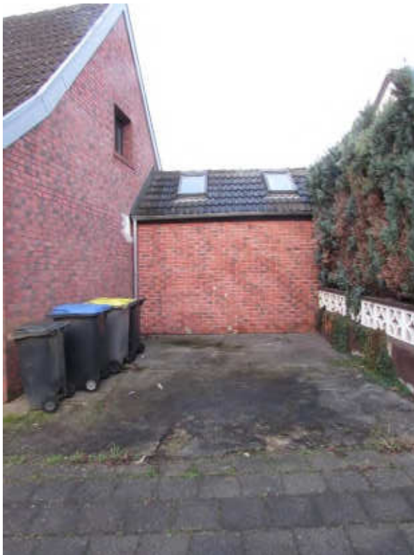
Foto 4: Anbau I und PKW - Stellplatz
