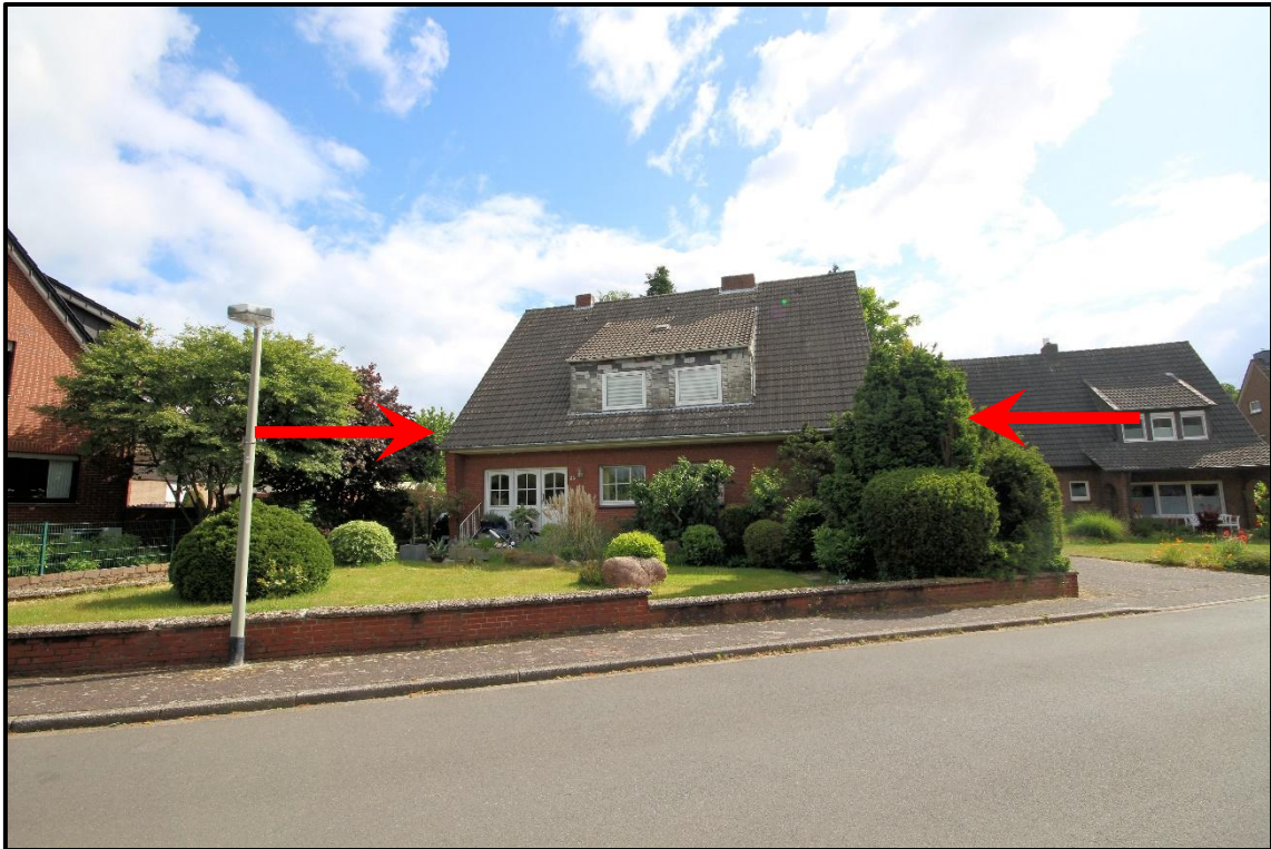
Bild 3: Ansicht von Westen
