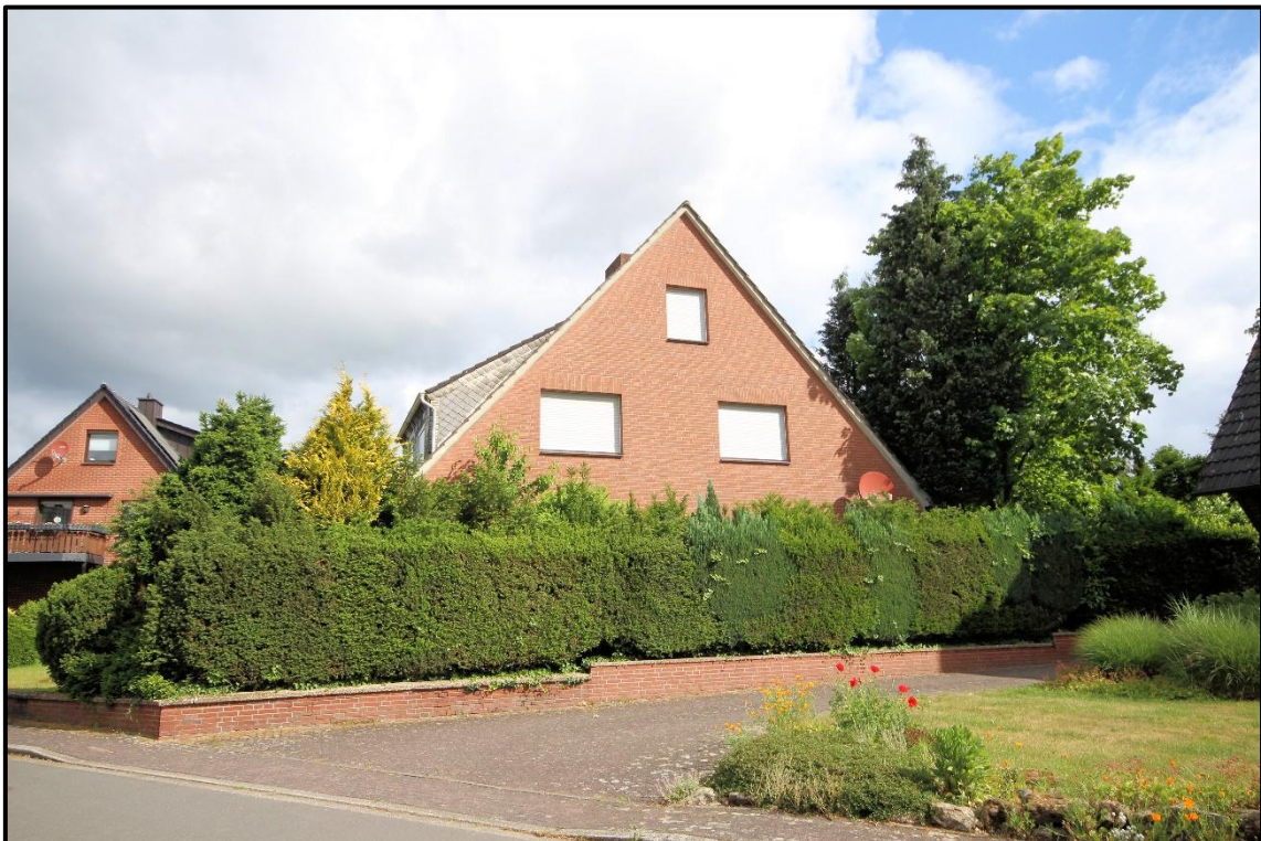
Bild 6: Ansicht von Süden
